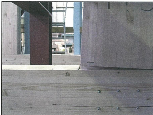
写真 5-77 試験体名：T75-2 回転による木材の圧縮めり込み 及び、引張割裂（南面）状況
