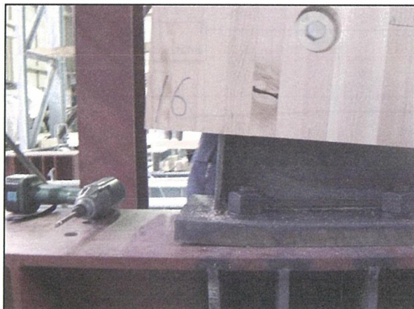
写真 5-27 試験体名 : 175-1 引張側のH鋼フランジの伸び・圧縮側のH鋼フランジの局部座屈状況
