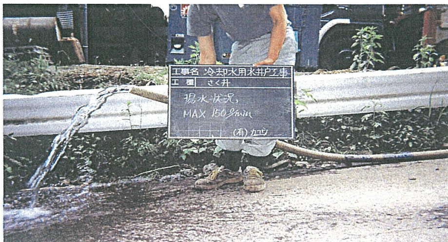
参考資料 5 掘削完了後の揚水状況
