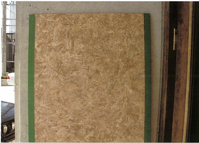
写真 16 コンクリート型枠用シート貼り（背面）
