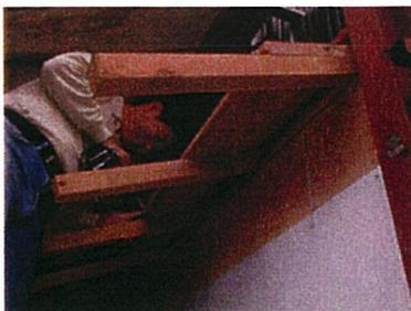
野地板はサネ加工した材料を用いる。野地板は90 mm以上のビスで約150 mmピッチで垂木と面戸板に留めつける。
