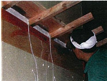
防火被覆として面戸板裏に塗る漆喰は、一回塗りで仕上げられる厚み（20 mm）とし、小ゴテで押し込むように詰め塗りする。桁と野地板に設けた小穴に漆喰を確実に充填する。取り付け部に隙間ができた場合、再度仕上げ漆喰を薄塗りする。
