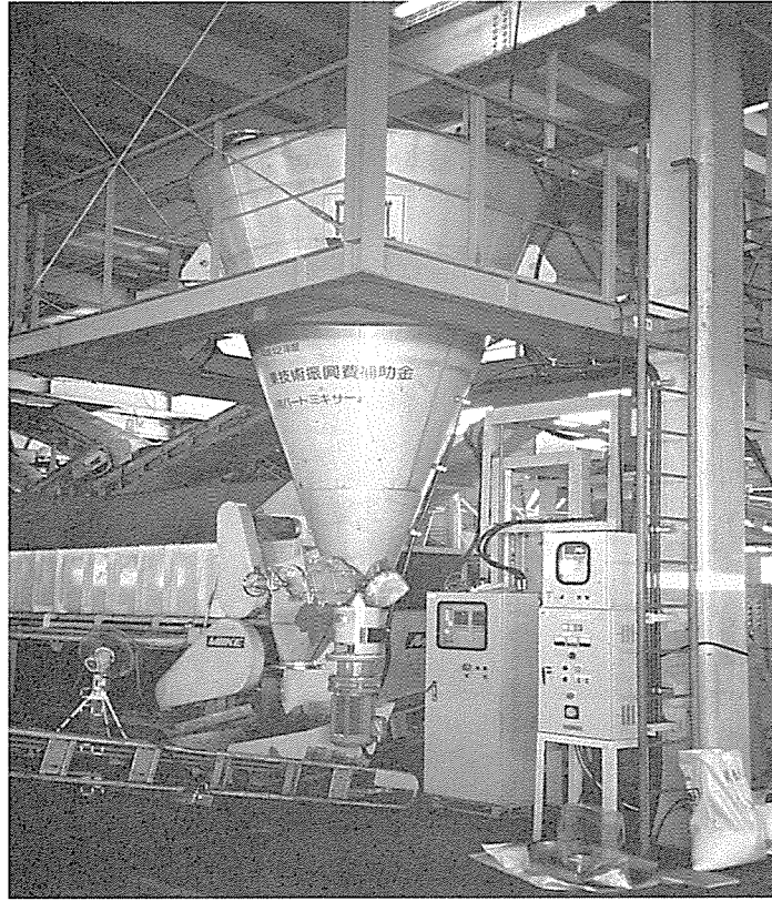
写真2 攪拌混合用のパートミキサー
