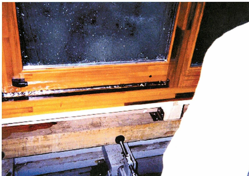
写真 14 水密性試験中の敷居付近の状況
