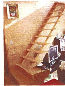
④ 階段のささらには天然乾燥のうえ製材したヒノキ、段板にも同じく厚さ33mmのヒノキを用いている。
