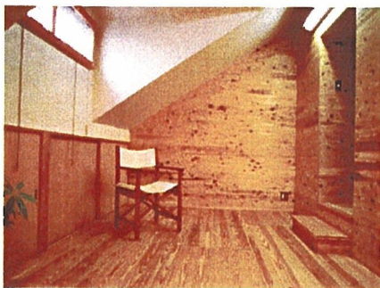
⑦ ロフトの壁にはスギ幅はぎパネルを素地のまま使用している。
