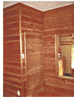
② 新設した建具には壁と同材のスギ合じゃくり加工製材品を使用し、水性ワックス1回塗り仕上げとしている。
