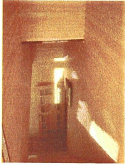
⑤ 2階より階段室を見る。壁はヒノキV目地本実加工品。
