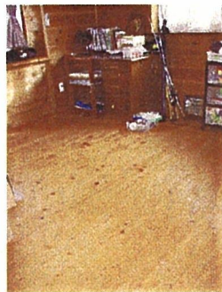
③ 床にはヒノキ本実加工製材品を無塗装で使用し、水性ワックス1回塗り仕上げとしている。
