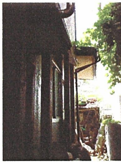
⑤ 基礎補強による通し柱を外部より見る。
