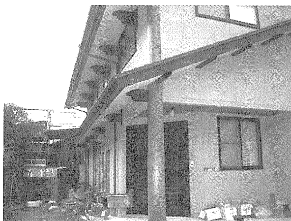
写真2-1 登り梁による大きな軒の出
