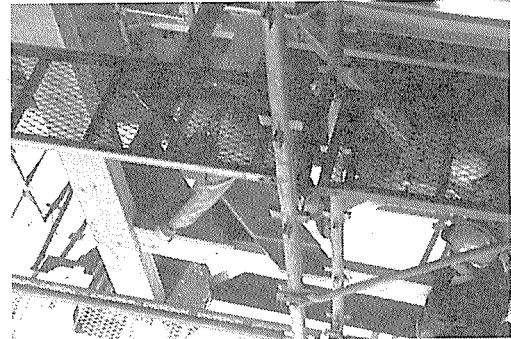
写真 3-9 1階の床板取り外し
