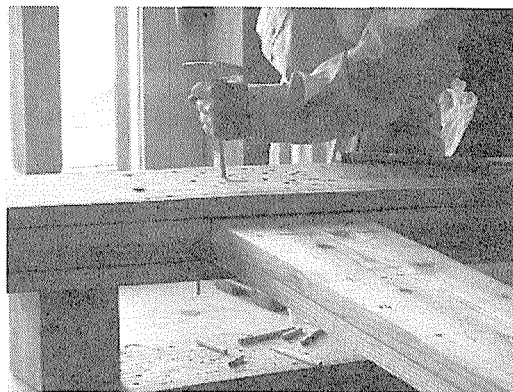
写真 3-17 地貫の木ダボ抜き(2)
