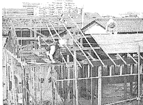
写真 5.13 構造材の撤去
