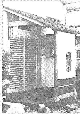
玄関ポーチの再使用 塗壁以外全ての木部再使用
