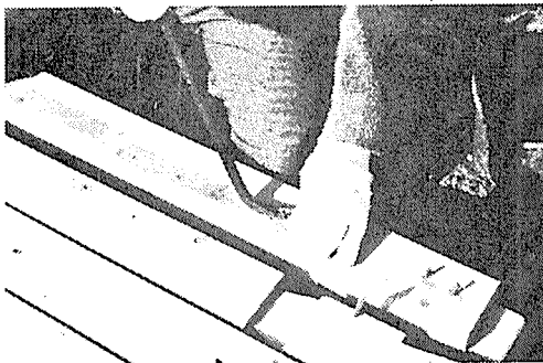
写真 5.32 パールによる釘抜き
