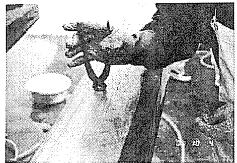
写真 5.33 ヤットコによる釘抜
