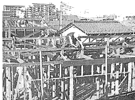
写真 5.14 小屋組の撤去
