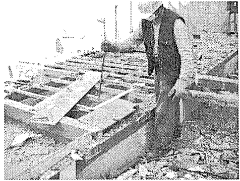
写真 5.20 1階床組の撤去
