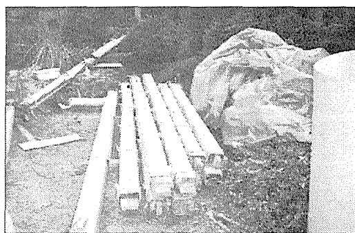
写真 5.23 再使用材の養生
