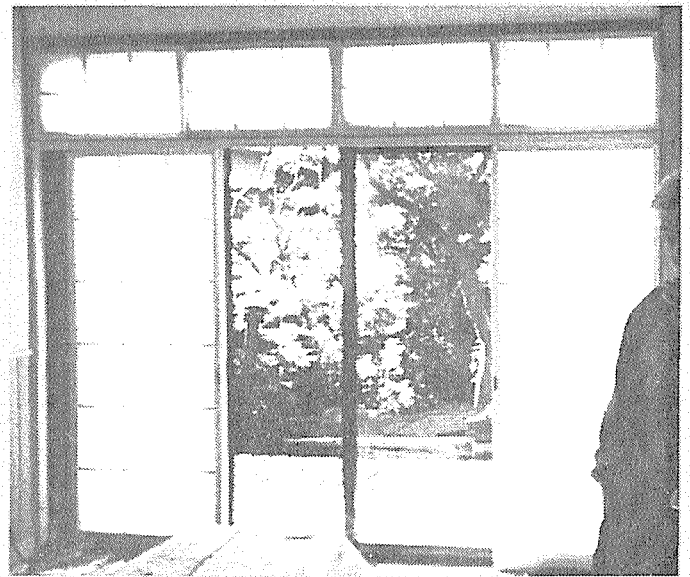
建具材の再使用 建具は高価なものであり、最初の段階で 撤去されるので再使用例が多い
