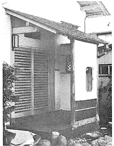
写真 5.44 玄関周りの再使用
