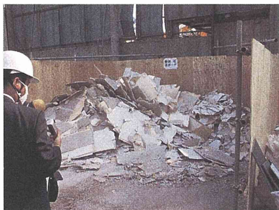
写真3 分別保管(石膏ボード)
