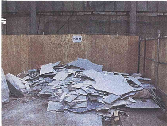
写真5 分別保管(外壁材)
