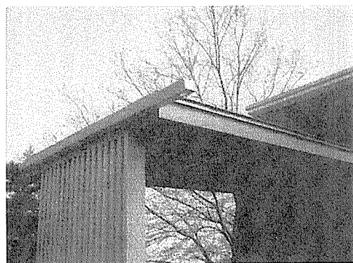
⑦増築した庇詳細。
