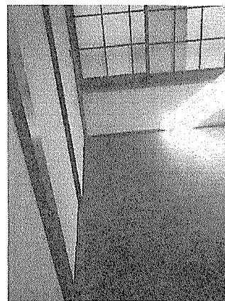
⑥2階寝室。(床はナラフローリング、床・天井はビニールクロス)
