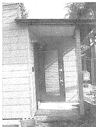
①玄関ポーチを見る。(軒裏はラワン合板)
