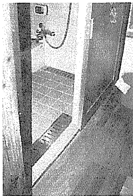
③脱衣室より浴室を見る。 (脱衣室床はナラフローリング)
