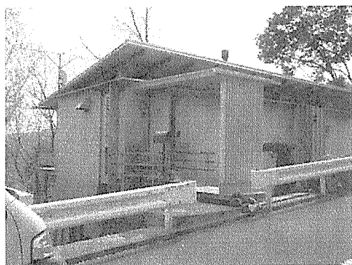
⑤増築した庇外観。
