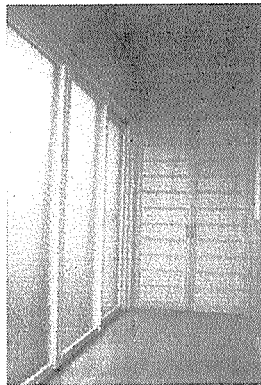
⑦1階に増築した縁側。(床はアカマツ緑甲板)
