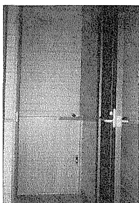
③増築した2階玄関。壁上部セン合板貼り、壁下部はスギ無垢板貼り。
