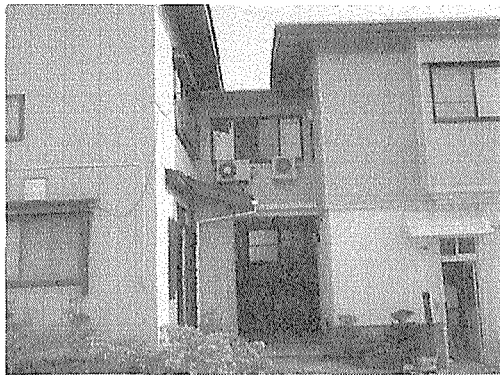
③2階居間と寝室をつなぐブリッジ。
