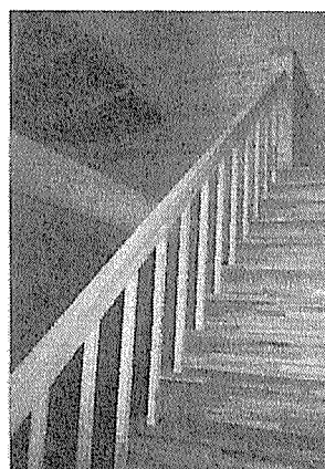
②1階ホール階段。(段板はタモ集成材)
