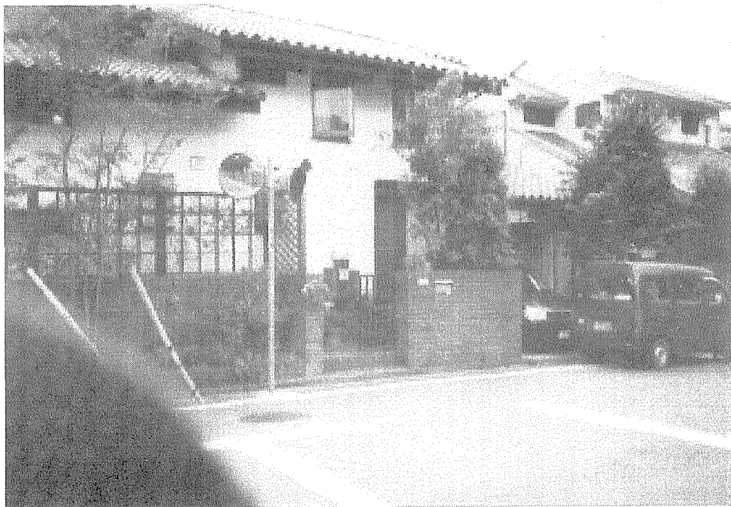
○リフォーム後の外観 (外部の外壁補修は平成2年に行ったものであり、今回は改修していない。)
