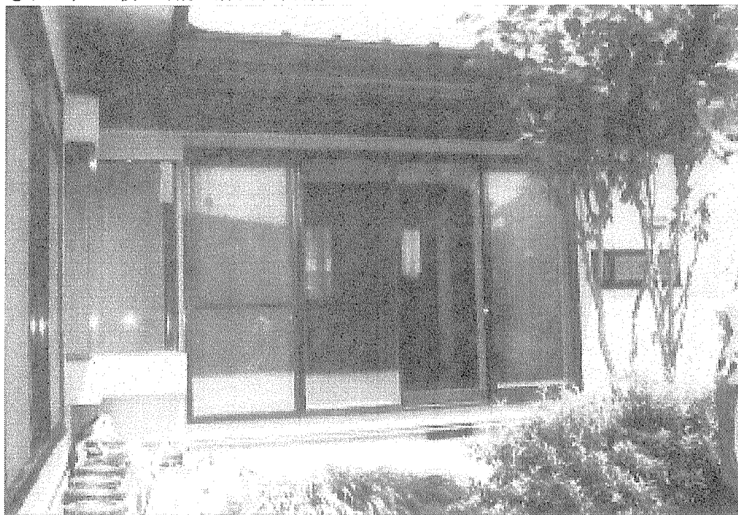
○リフォーム後の外観（縁側増築部分）
