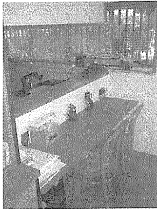
①新設した台所カウンターを見る。 (カウンターはナラ集成材)
