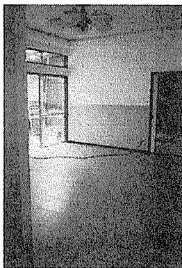
③1階洋室。(床はコルクタイル、壁・天井はビニ ールクロス)
