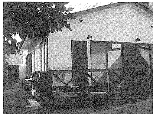
④増設したテラス。
