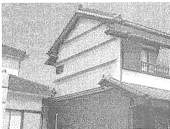
写真1 切り妻屋根の妻面と小庇 (安芸市)
