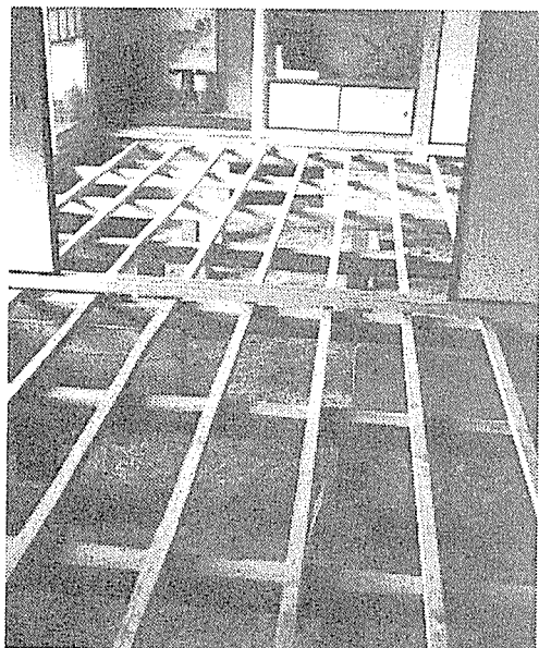
写真 25 大掃除時に床下清掃と床下点検のために畳、床板をあげた状態（三木浦）
