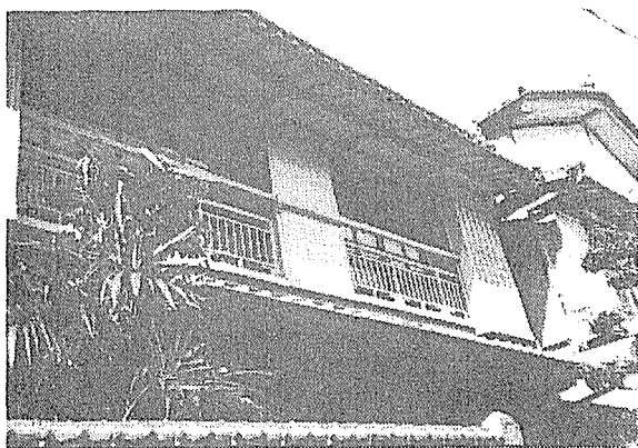
写真 5 出し桁形式により深い軒の出を確保した例（九鬼浦）
