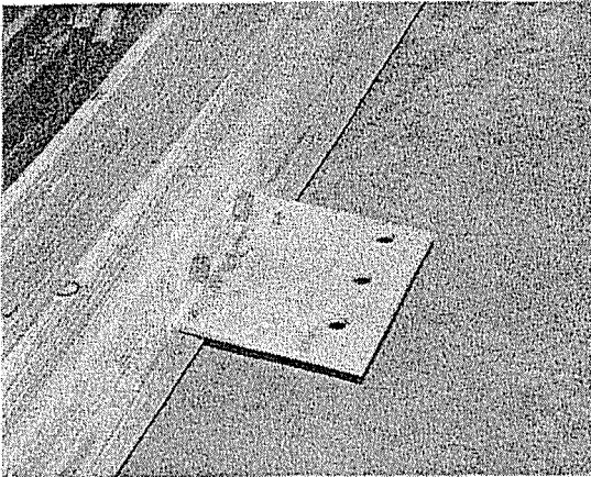
接合写真2-1 記号GJ-2 T型金物
