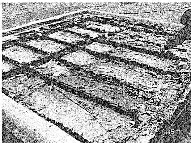
壁No. 6 終了後の軸組燃焼状況
