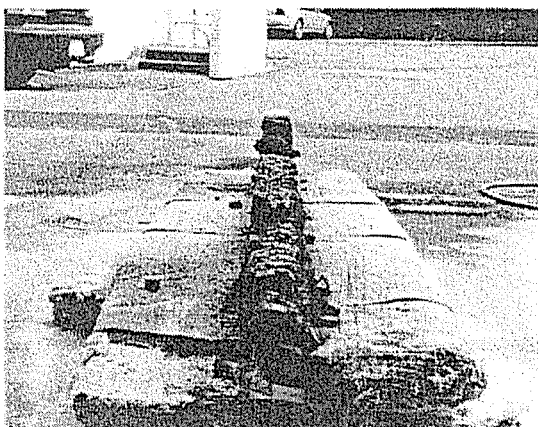
梁写真4-15 記号B-4 試験終了後、梁の炭化状況
