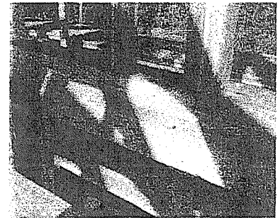
妻小壁下枠45×120 妻小壁たて枠45×120@1820/3
