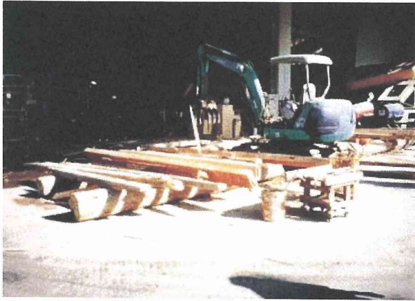
《調査写真 5.6》 柱、梁桁類の金具除去作業
