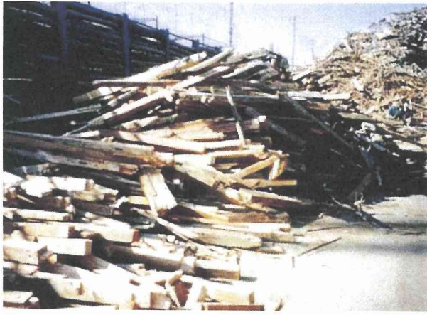
《調査写真 5.5》 住宅解体材(柱、梁桁類)
