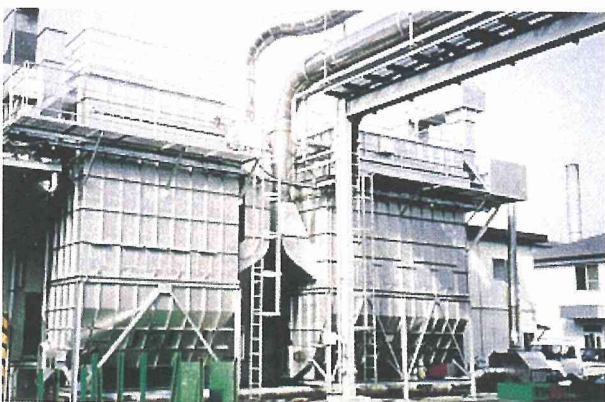
《調査写真 10.8》 木くず焚きボイラー用発電機(郷原工場)
