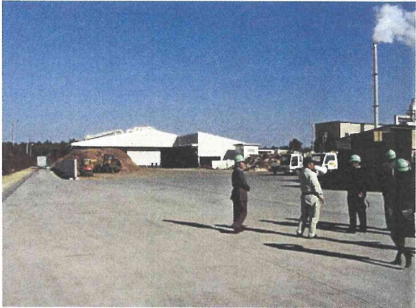
《調査写真 1.6》 工場全景
