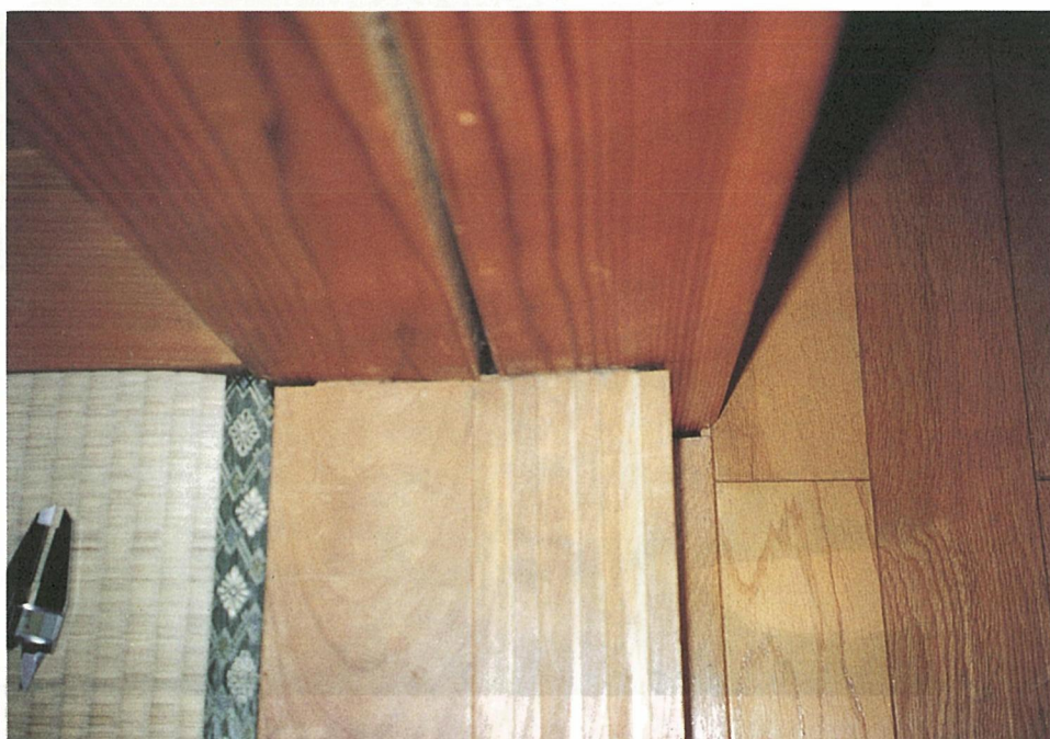
写真2 柱下部で生じた敷居との隙間
