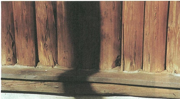
写真9 B地区 縦使い、回廊上に庇あり校木損傷無し
