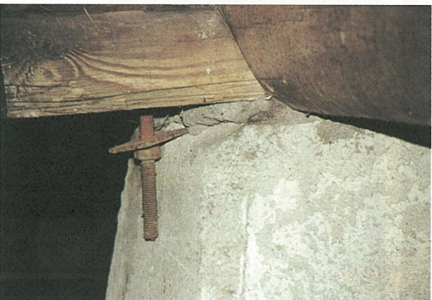
写真4 " 経過年数26年のコテージの軸ボルトのゆるみ
