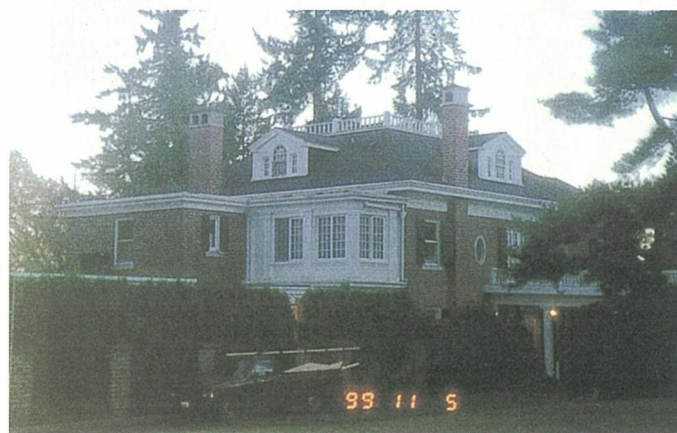
写真7-7 視察対象となった増築現場の建物外観
