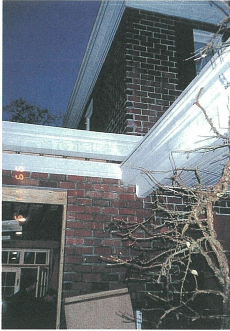
写真7-8 増築部分（左側）と既存部分（右側）のつなぎ目
