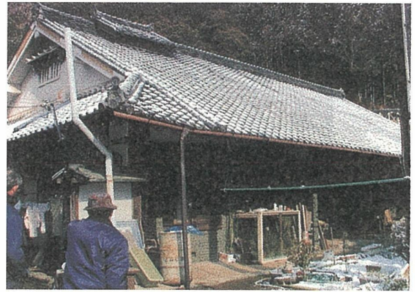
写真2 南家全景 土間、玄関部分は改修されている
