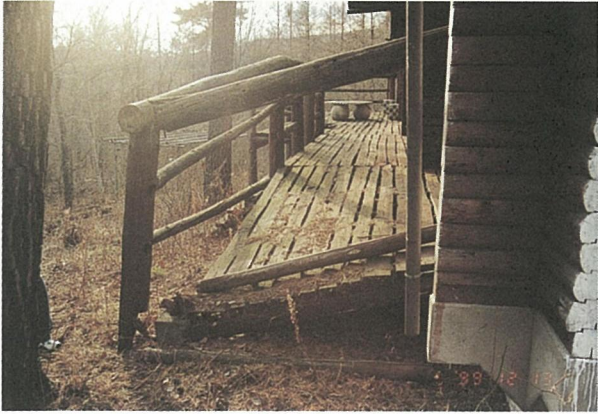
写真25 写真24の右側落ちたベランダ
