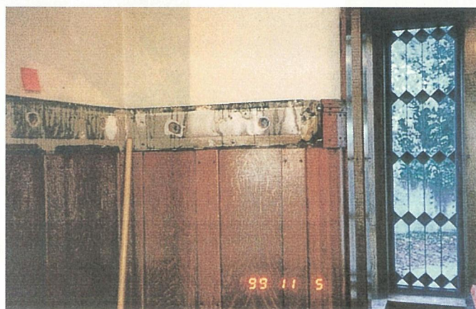
写真7-3 サブリビングのリフォームの様子
