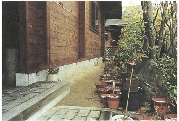
写真-9 玄関先 角ログの木口の覆い
