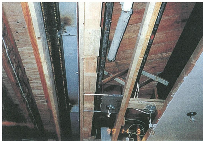
写真7-10 同じく増築部分（写真左側）と既存部分（写真右側）の床組を見上げ
