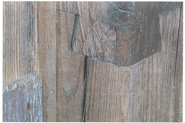
写真8 写真7の詳細 継ぎ手は斜め方向にあり継ぎとしている
