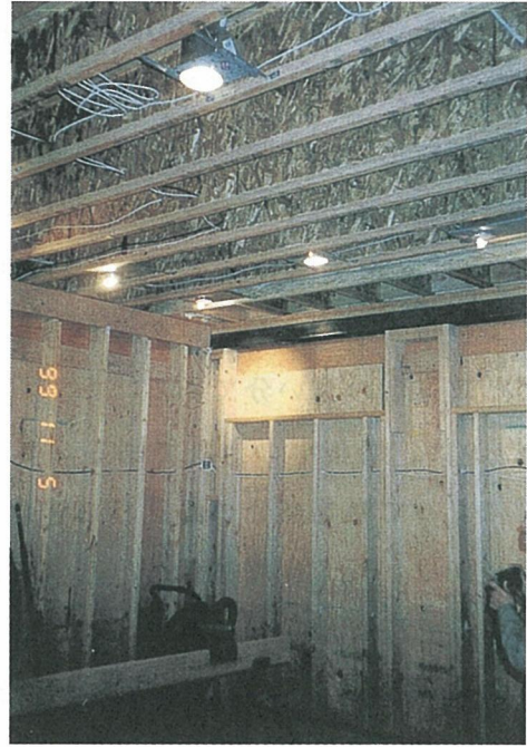
写真7-9 増築中の台所
