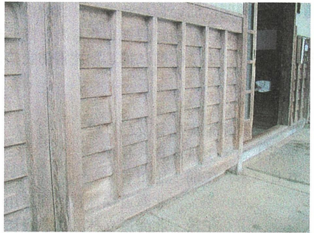
写真16 竜泉寺庫裏 土間の外壁 スギの厚い板でさらさら子下見板張り としている
