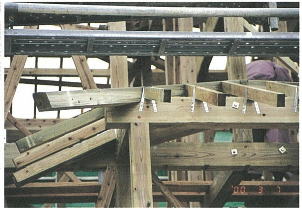
写真-6 隅棟、たるき材はCCA処理
