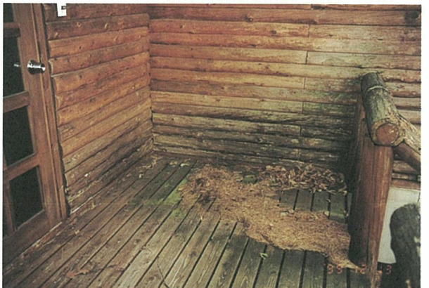
写真22 玄関ポーチの校木の腐朽
