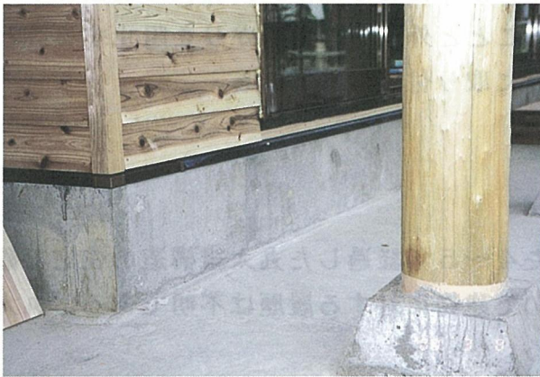
写真-2 外周布基礎換気口なし、独立柱は土庇の柱
