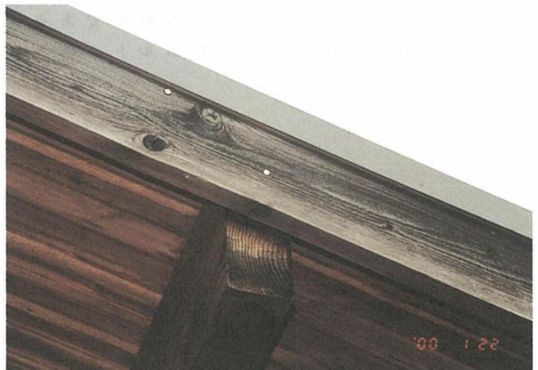
写真-11 屋根梁と破風板
