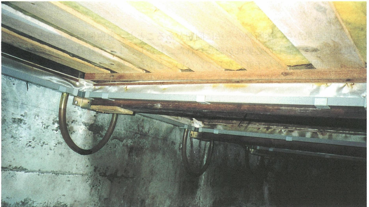
写真2 長谷川邸の床下 (再処理のパイプが見え、ほぼ健全である)
