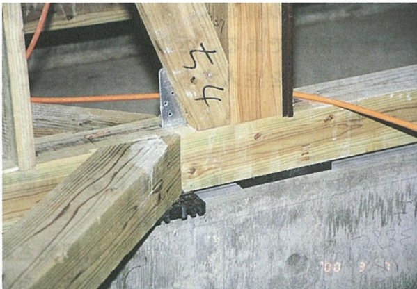
写真-3 土台下パッキン、パッキン厚み間隙が換気口となる
