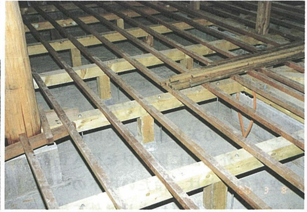
写真-5 大引の地盤への緊結
