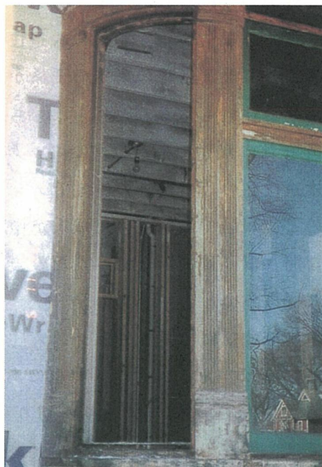
写真7-12 外壁の補修の様子
