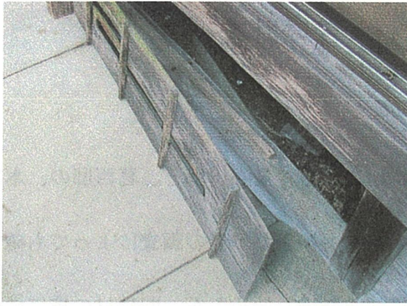
写真13 竜泉寺庫裏 写真12の蹴込み板を外したところ
