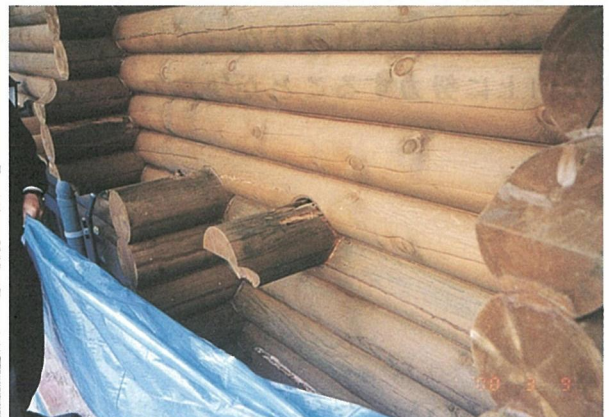
写真-8 イエイロアリによる被害
