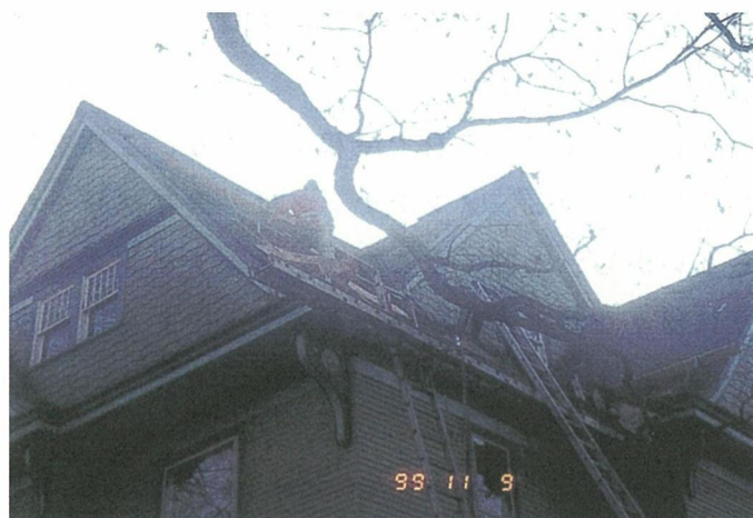
写真7-13 築後約100年近く大規模な木造住宅の屋根のメンテナンス作業状況
