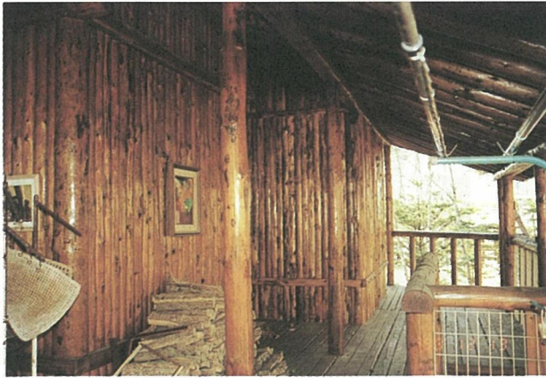
写真9 B地区 縦使い、回廊上に庇あり校木損傷無し
