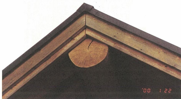
写真-16 棟木と破風板
