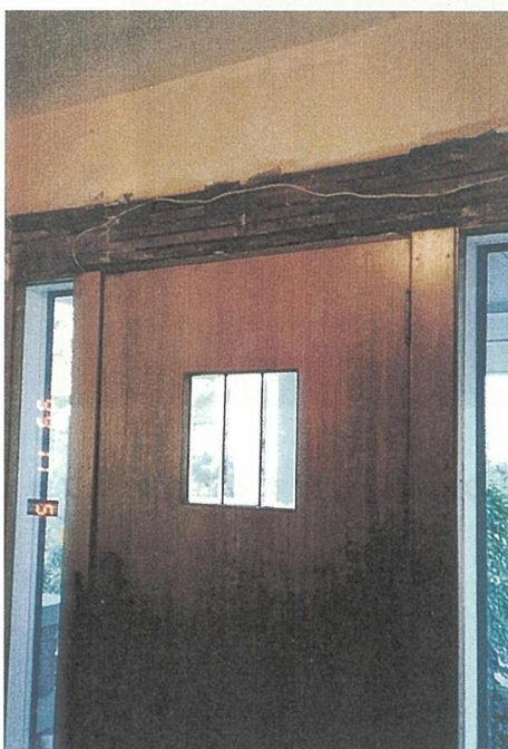
写真7-2 玄関ドア周りのリフォームの様子
