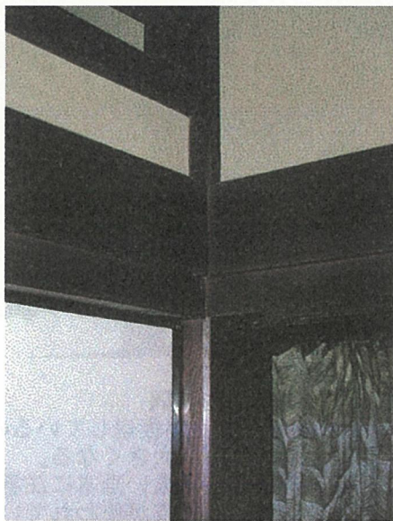
写真9 南家、座敷内部 柱と指鴨居の仕口部分
