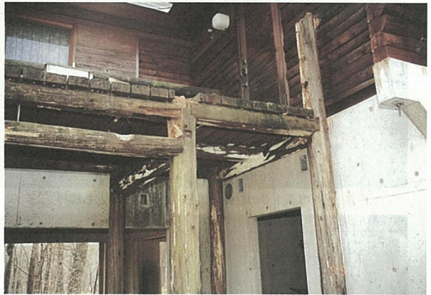
写真29 側桁の取りつき部分
