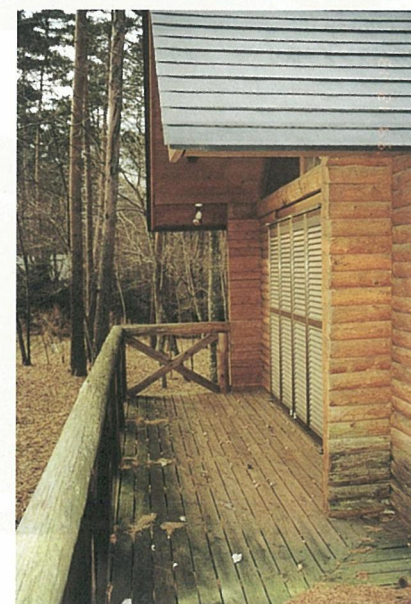
写真22 玄関ポーチの校木の腐朽
