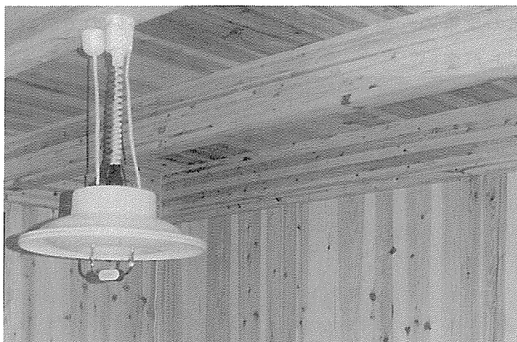
図4-28. スギ中断面集成材を梁に用いた「スギの家」
