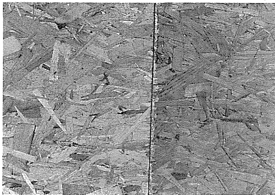
図4-7. 屋外暴露によるOSB表面の変色。左が暴露前、右が暴露1年後。
