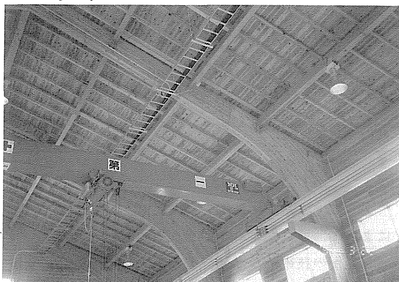
図4-30. スギの大断面構造用集成材を用いた工場
