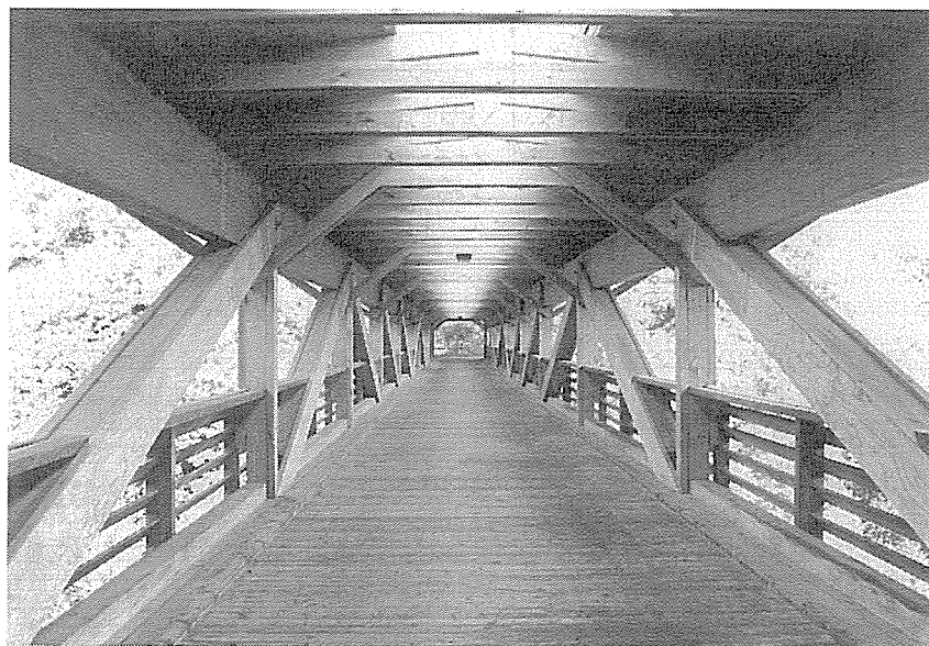
図3-19. 構造用LVLを用いた木橋の斜材
