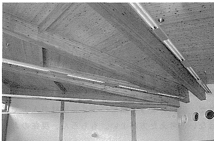
図4-29. 外層にベイマツ、内層にスギを用いた複合集成材
