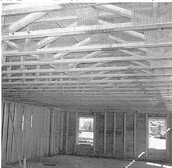
図3-45. メタルガセットによる平行弦床トラス
