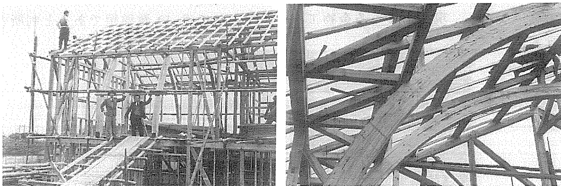
図4-6. 構造用集成材がわが国で初めて用いられた構造物(森林記念館:昭和26年完成)
