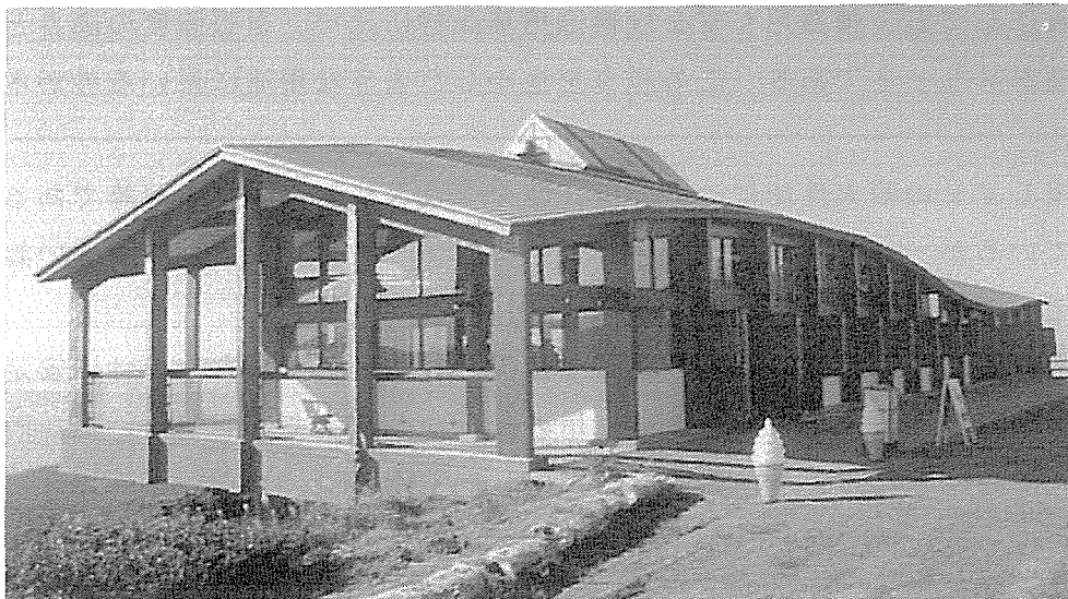
図3-23. 大断面構造用LVLを多用したレストラン
