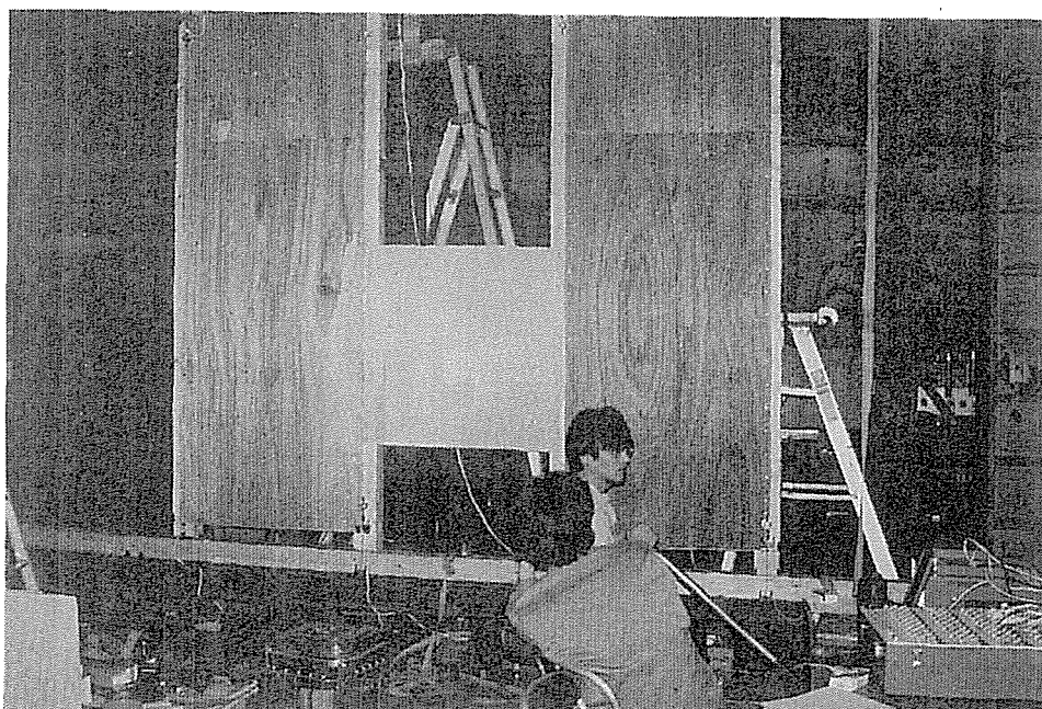
写真1.4 有開口壁の水平加力実験（3P-2、3、6試験体）
