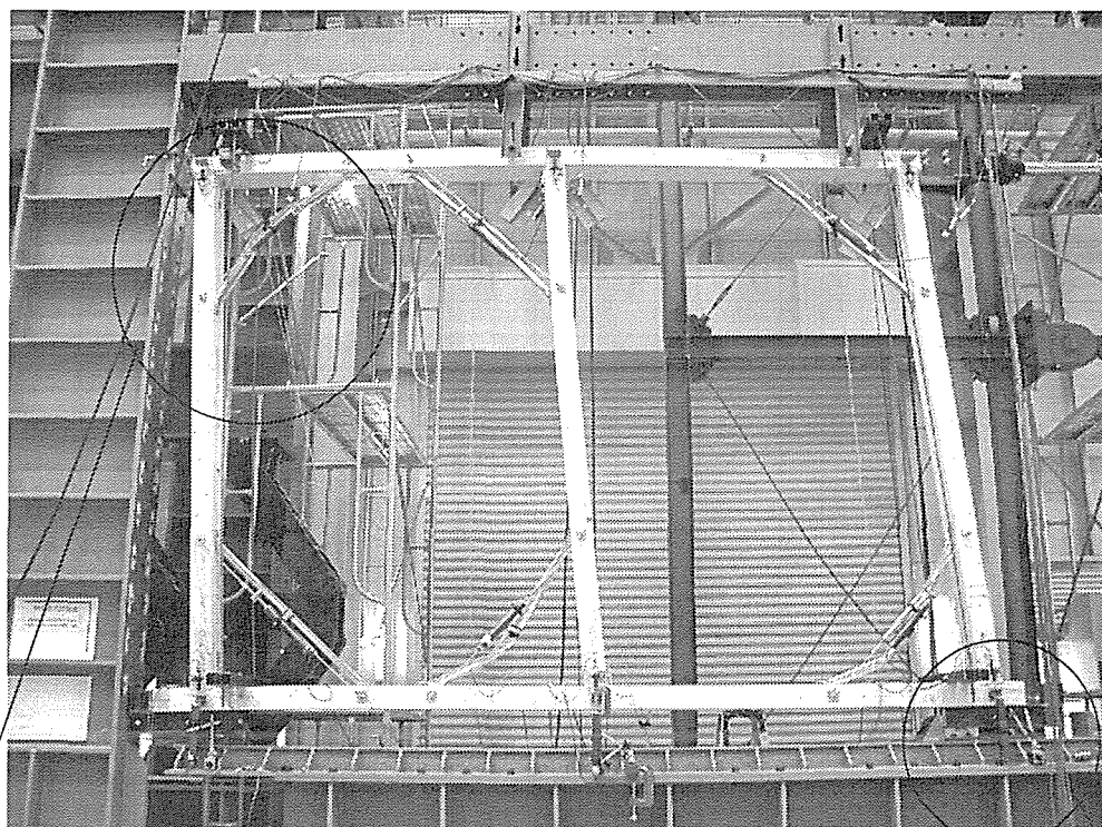
写真2-14 180-6 火打ちの座屈状況 (押し1/15rad時)
