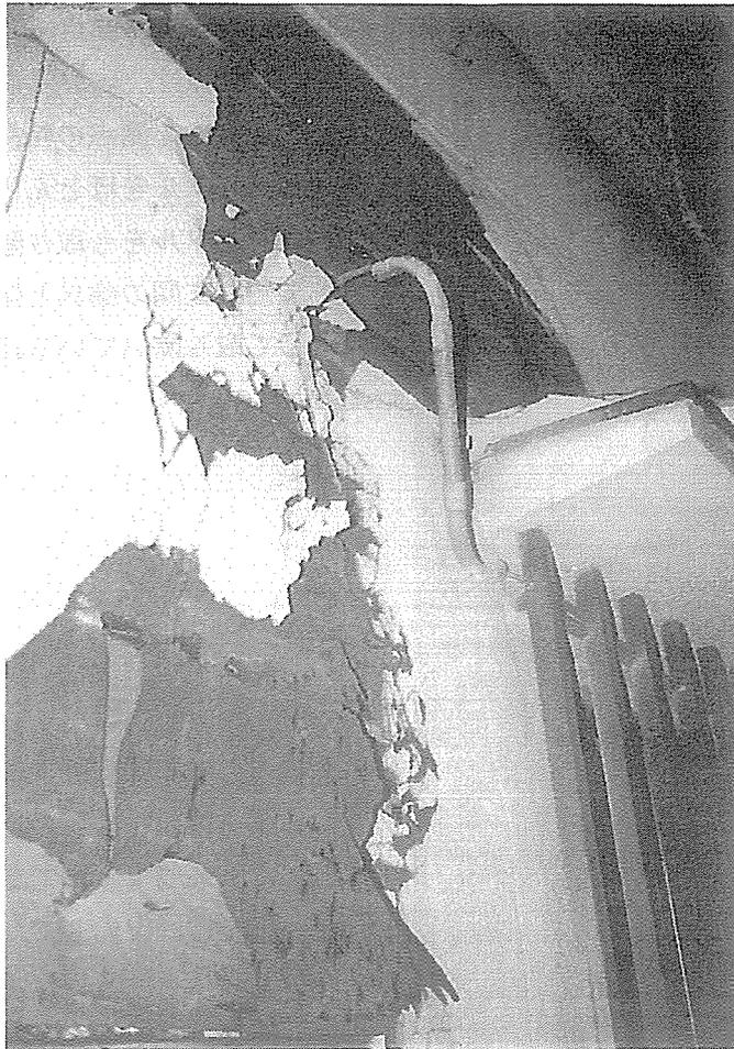
写真48 外壁モルタルのカット面及び取り外し面を示す
