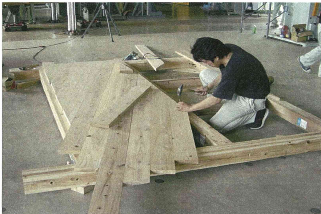
写真4 斜め張り試験体施工状況
