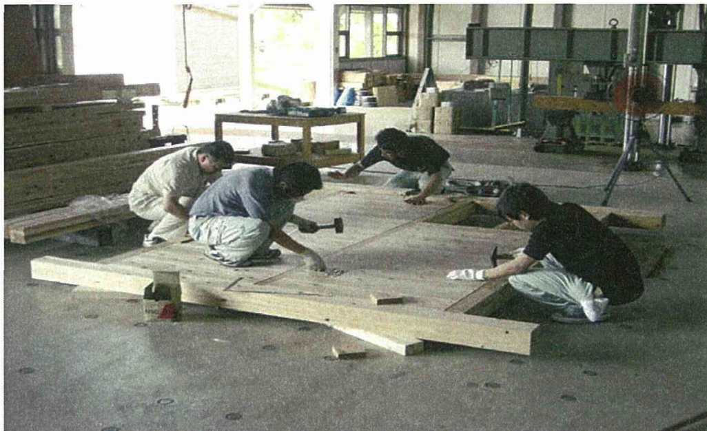
写真3 横張り試験体施工状況
