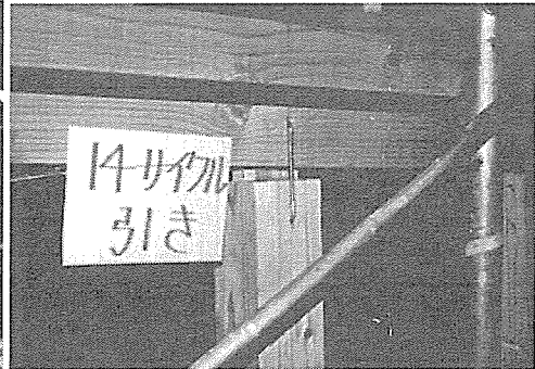
写真 2. 3. 6 14C 中柱柱頭浮き上がり
