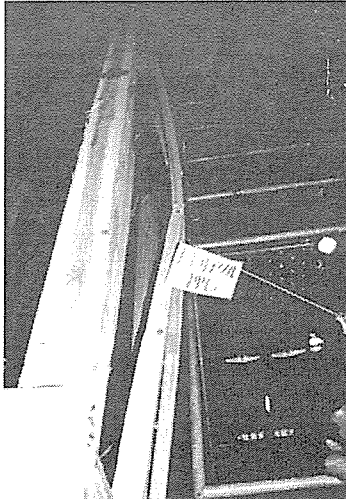
写真 2. 3. 5 14C 筋かい座屈
