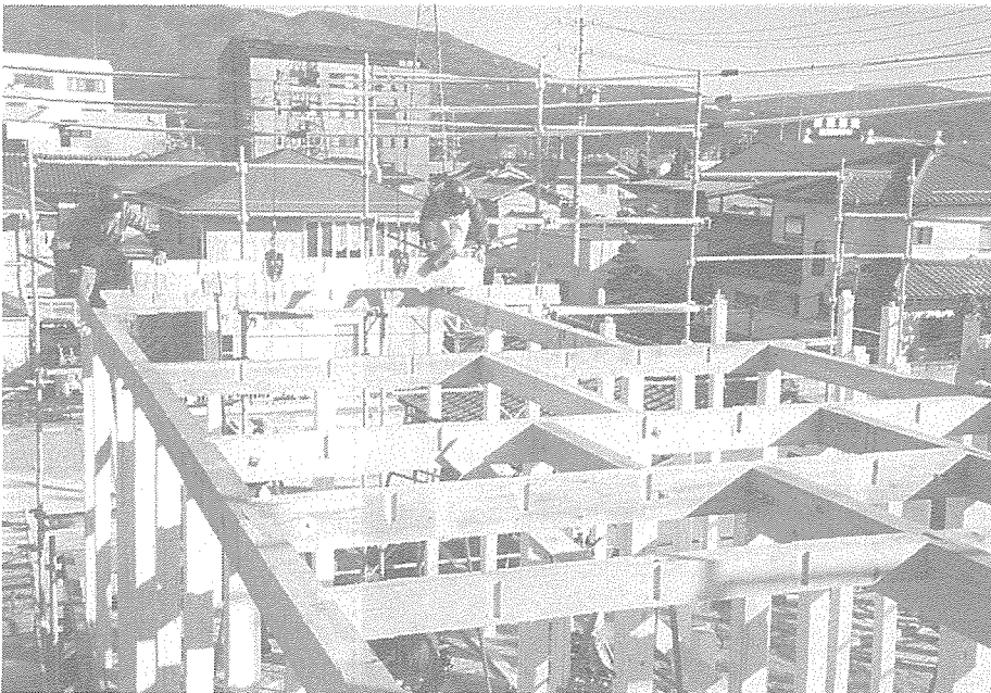
施工 14：二階建て方
