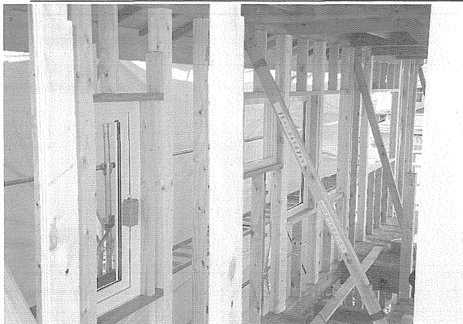
施工 30：サッシ枠取付
