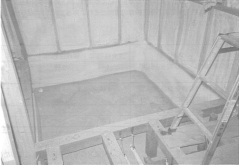
ウレタン吹き付け断熱工法。容易に気密・断熱の確保ができる。2名×2日で施工。
