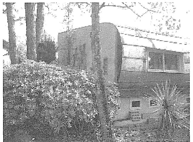
写真 2. 13. 4. 13 建物北側外観 (建物 F)
