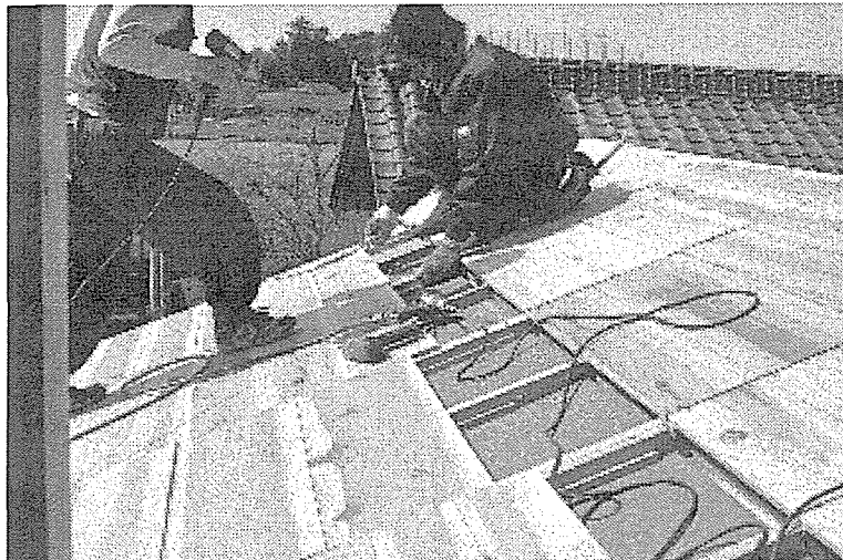
屋根パネルの施工
