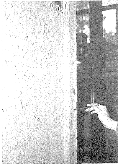
写真9 地貫上側で壁土の盛り上がり(No.3a)
