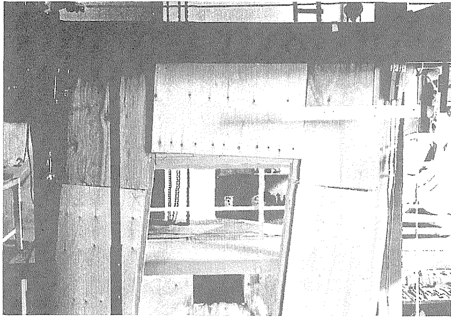
写真 6-23 門型大壁補強 (1/15rad 時、面材の破壊状況)
