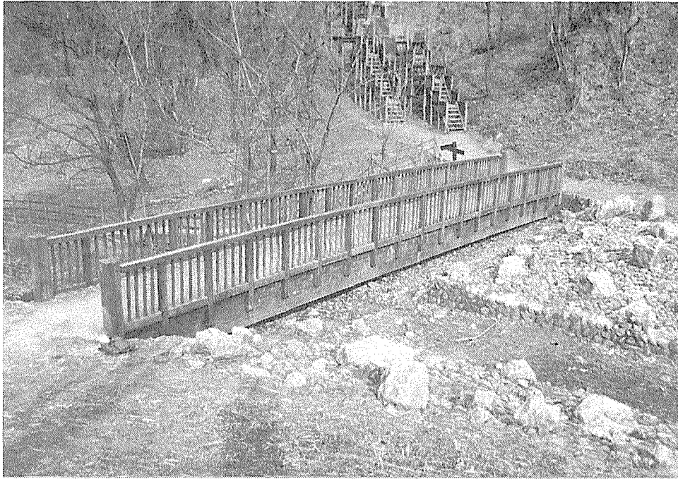
写真9 長沼公園桁橋全景（南西から）
