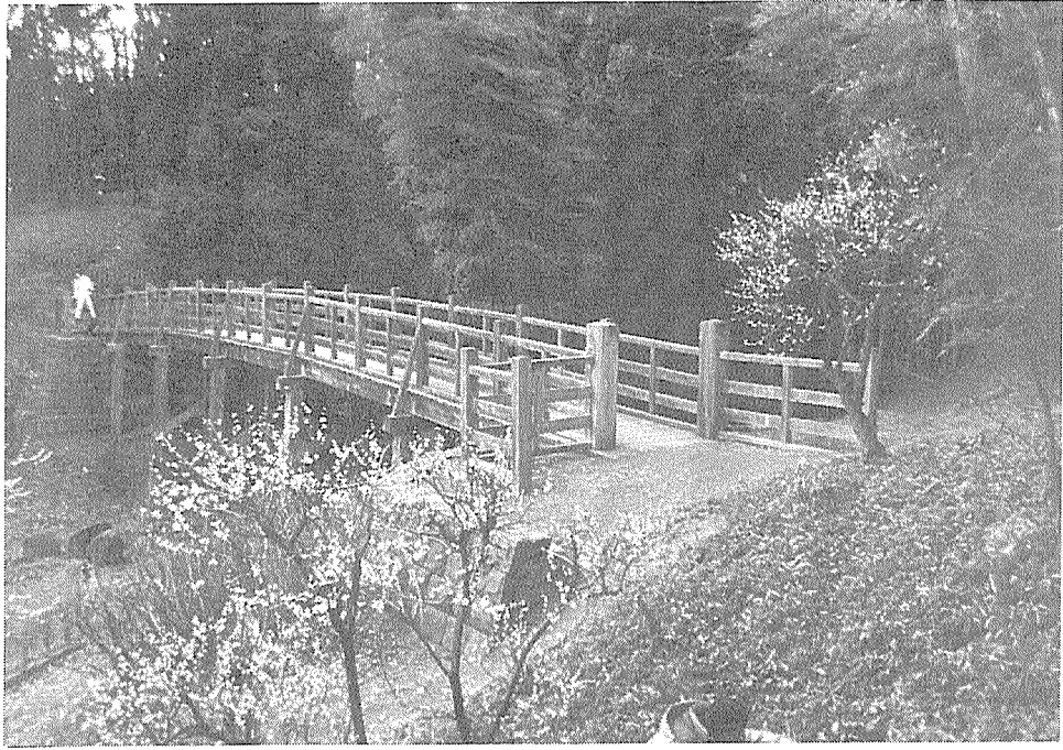
写真11 原峰公園桁橋全景（南東から）
