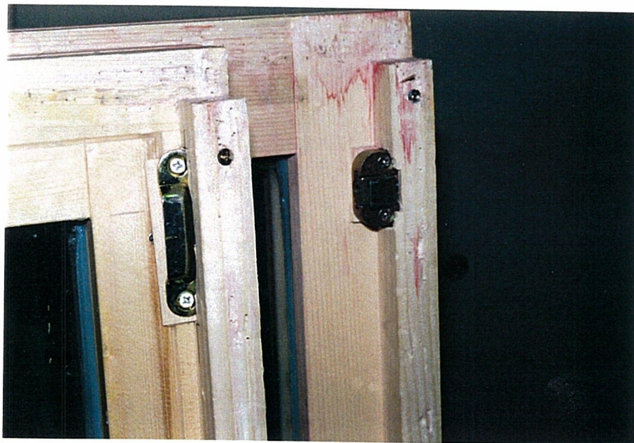
写真 2 - 2 召し合わせ部分の引き寄せ金具（中間ロック）
