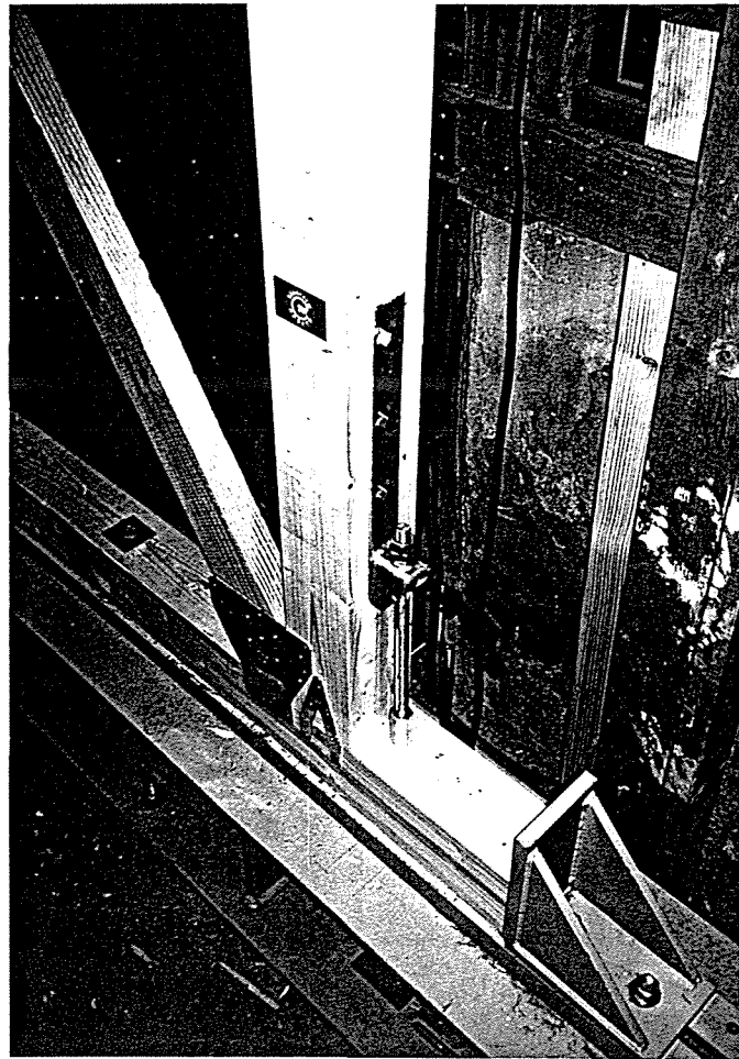
写真2 ホールドダウン金物 (S-HD15) の取り付け
