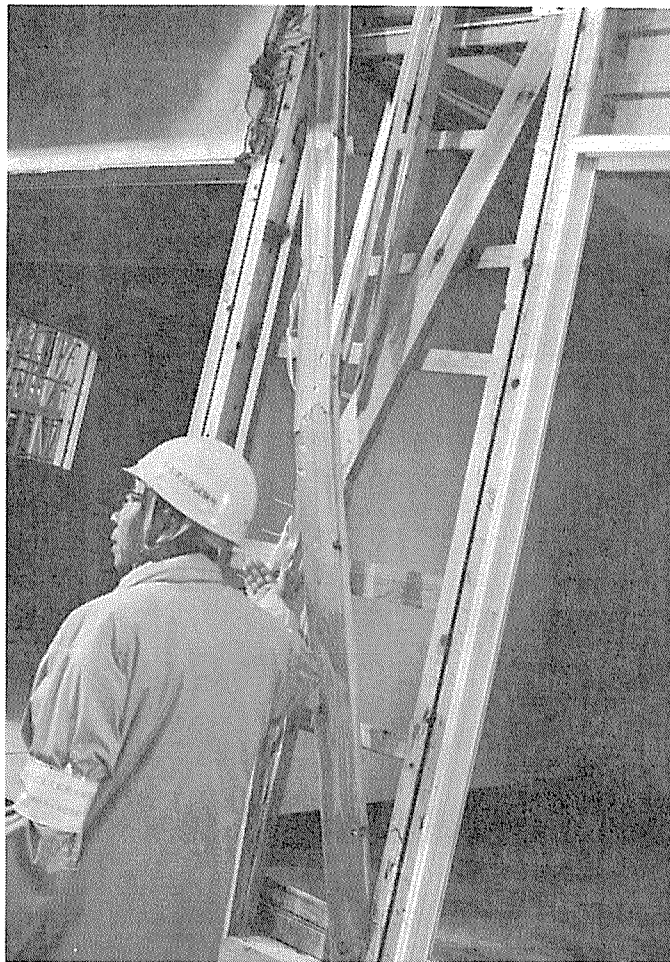
写真B-8 フェーズ4、NO.10終了後 筋かいの座屈
