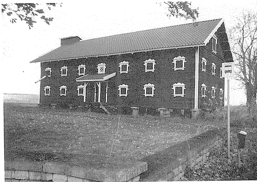
約200年前の穀物 倉庫。 校倉式で高床になっ ている。
