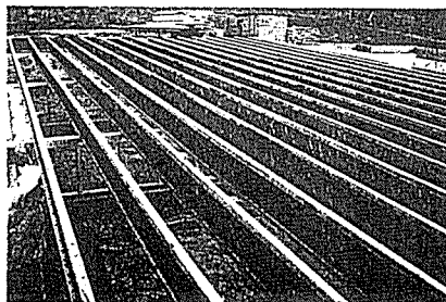
床根太に使用されたTJIジョイスト。ジョイストの長さは12m。
