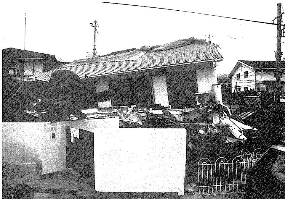
〔写真 6〕 新築7年で倒壊し た住宅。 （神戸市東灘区）
