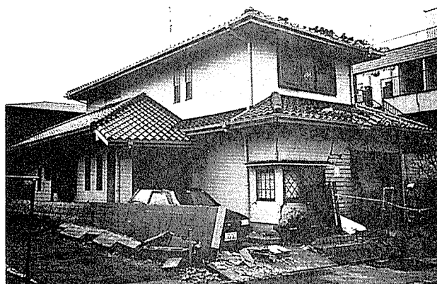
建物全景北西面 1階に大空間があり偏心が大きい。
