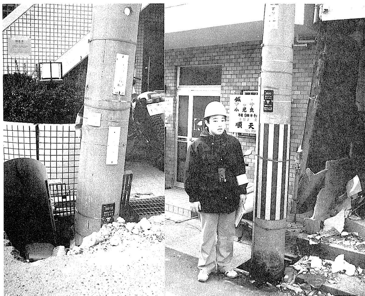
〔写真 28〕 電柱が地中にめり込んでいる。地下 では液状化が起きているようだ。 (神戸市東灘区)
