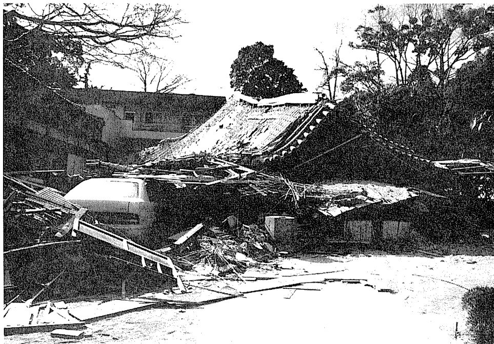
〔写真 33〕 軸組が完全に倒壊 した寺院。 （神戸市須磨区）
