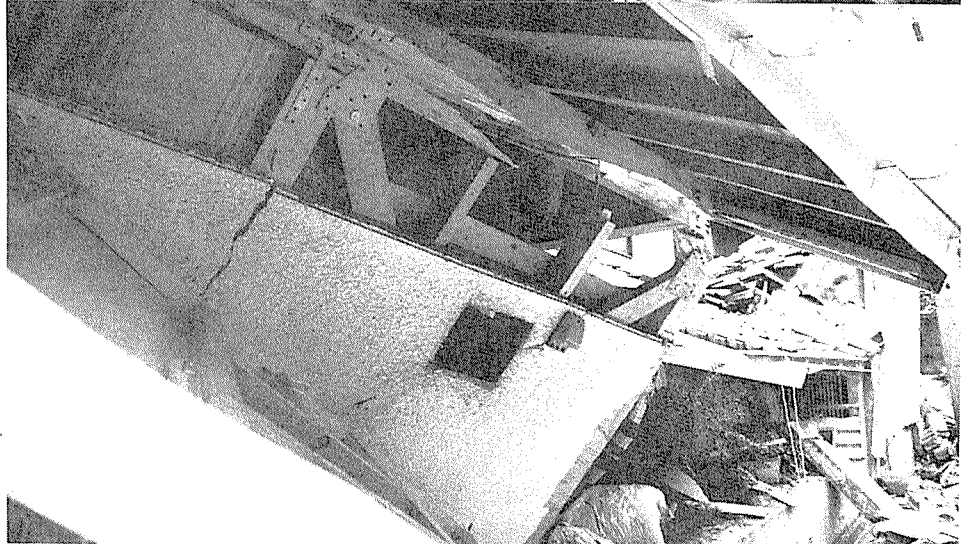
〔写真 8〕 同上住宅詳細。筋 かいプレートが用 いられていた。横 架材を引き裂いて いる。
