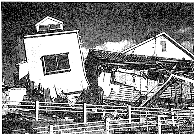
建物全景西面
