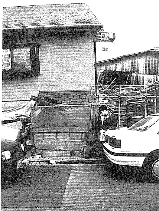
建物東面 約2.5m隣の敷地に倒れかかっている。
