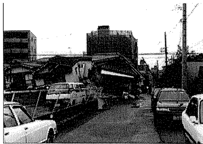
ねじれによる建物の倒壊 偏心した建物のねじれは、屋根や2階が重いと一層苦しくなります。
