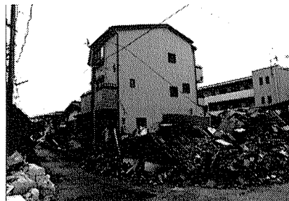
3階建て木造住宅の無被害 構造計算を行ったであろう新しい3階建て住宅は、ほとんど被害は軽微でした。
