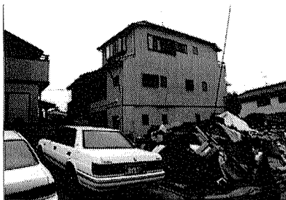
3階建て木造住宅の被害 外壁のモルタルに亀裂が入っています。この建物では、1階よりも2階部分の方が大きく変形しました。
