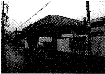
ねじれによる建物の倒壊 壁配置のアンバランスは、建物にねじれを生じさせます。敷地外へ倒れ込んだ建物が道路をふさいだ例はたくさん見られました。
