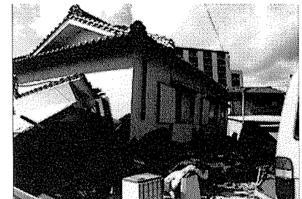
伝統工法を取り入れた新しい建物の被害
