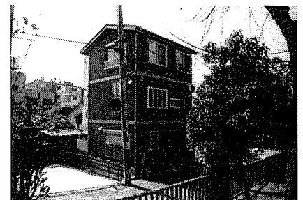
3階建て木造住宅の無被害 周囲の古い建物が倒壊する中で、新しい3階建て住宅が、無被害で残っている例はいたるところで見受けられました。
