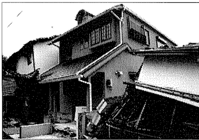
無被害建物 大部分の新しい建物は無被害でした。特に間口方向にも壁がたくさん入ったものは被害が軽微でした。
