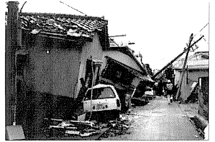
建物の横転 横転した建物で、車が押しつぶされている例がたくさん見られました。1階の一部を車庫とした建物も多かったものと考えられます。
