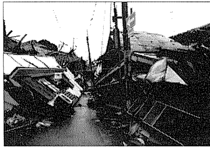
古い建物の全壊
