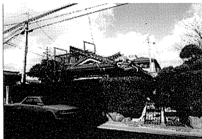
伝統的民家の倒壊
