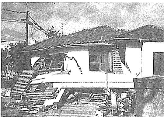
写真4 1階間口部分に耐力壁がほとんどない住宅の被害（芦屋市）
