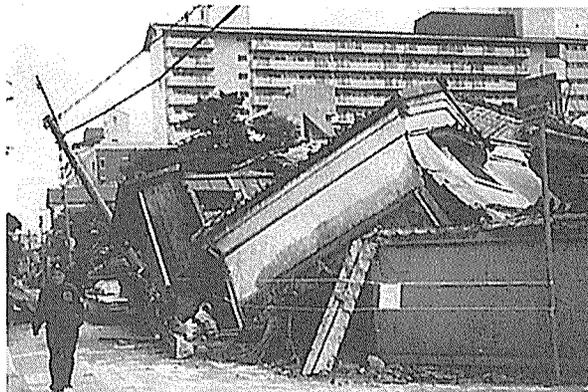
写真11 1階部分が倒れた土蔵(芦屋市)
