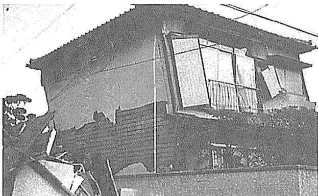
写真2 木づくりだけで筋違いのない住宅の被害（芦屋市）
