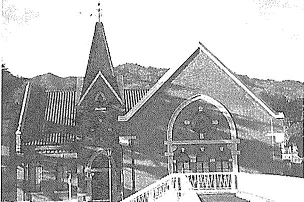
写真15 RC耐力壁と集成材アーチ屋根の組み合わせ。構造的な被害なし(灘区)
