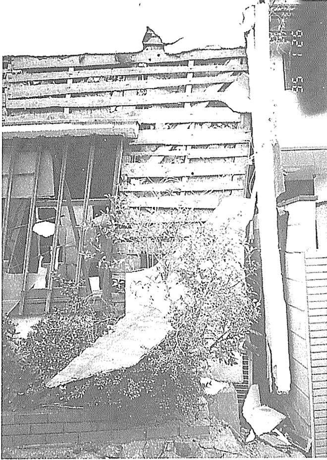
写真2.5.3.29 筋違いが「K」字に挿入されている建物（東灘区）
