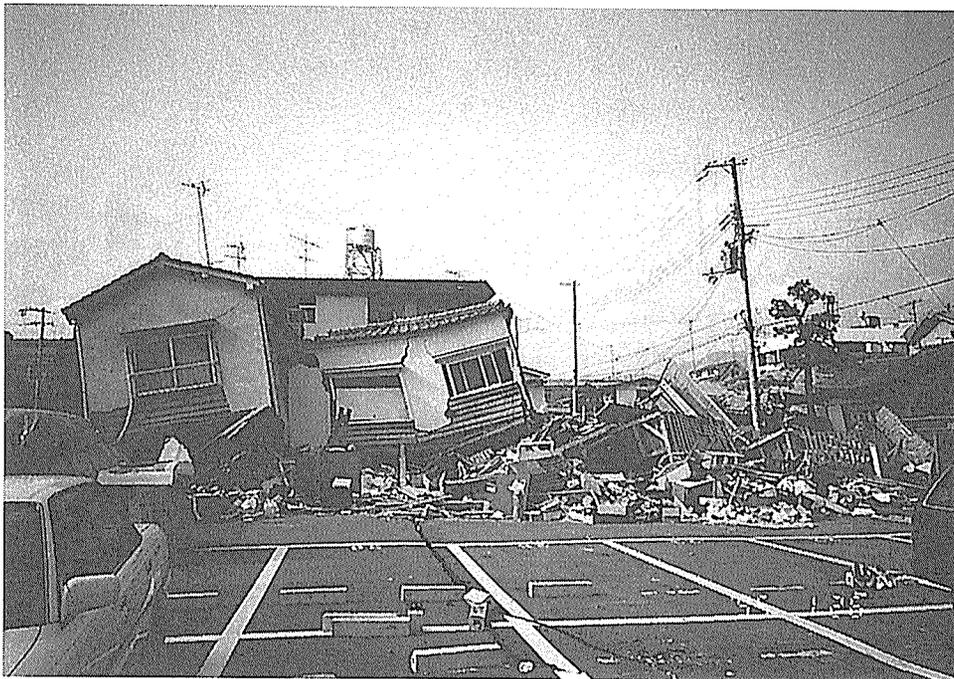
写真2.5.3.3 1階が層崩壊した2階建て住宅（東灘区本山中町）
