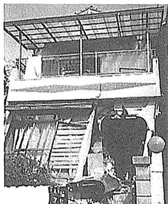
写真8 間口に耐力壁(片筋違い)が91cmしかないミニ開発住宅の被害(宝塚市)
