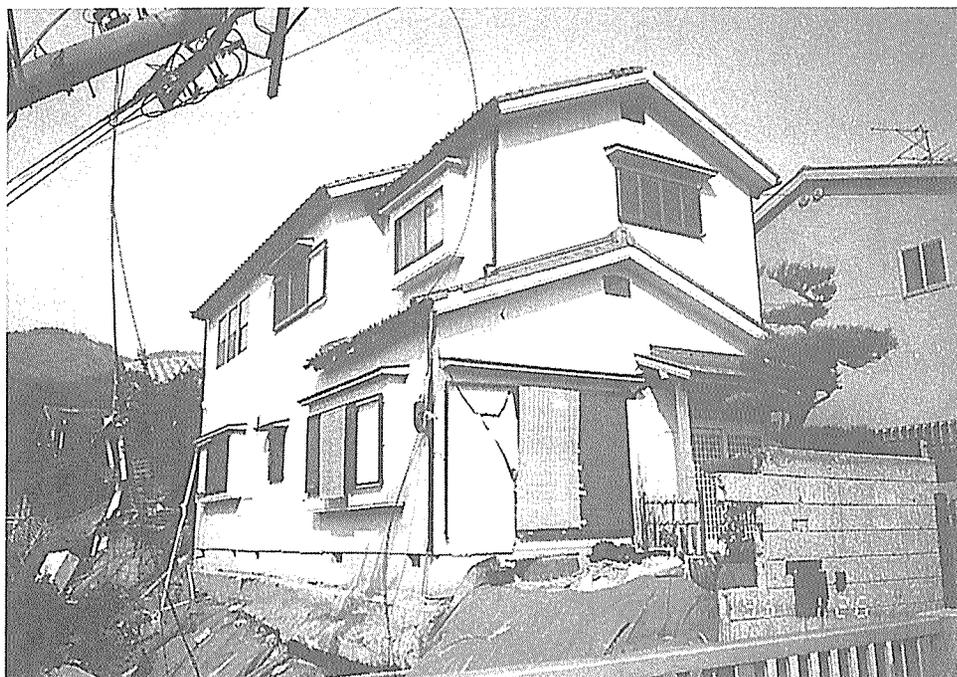
写真2.5.3.41 地盤が移動して基礎が露出した2階建て建物
