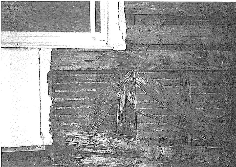
写真2.5.3.28 窓下に伸ばされた変則的な筋かい (東灘区)
