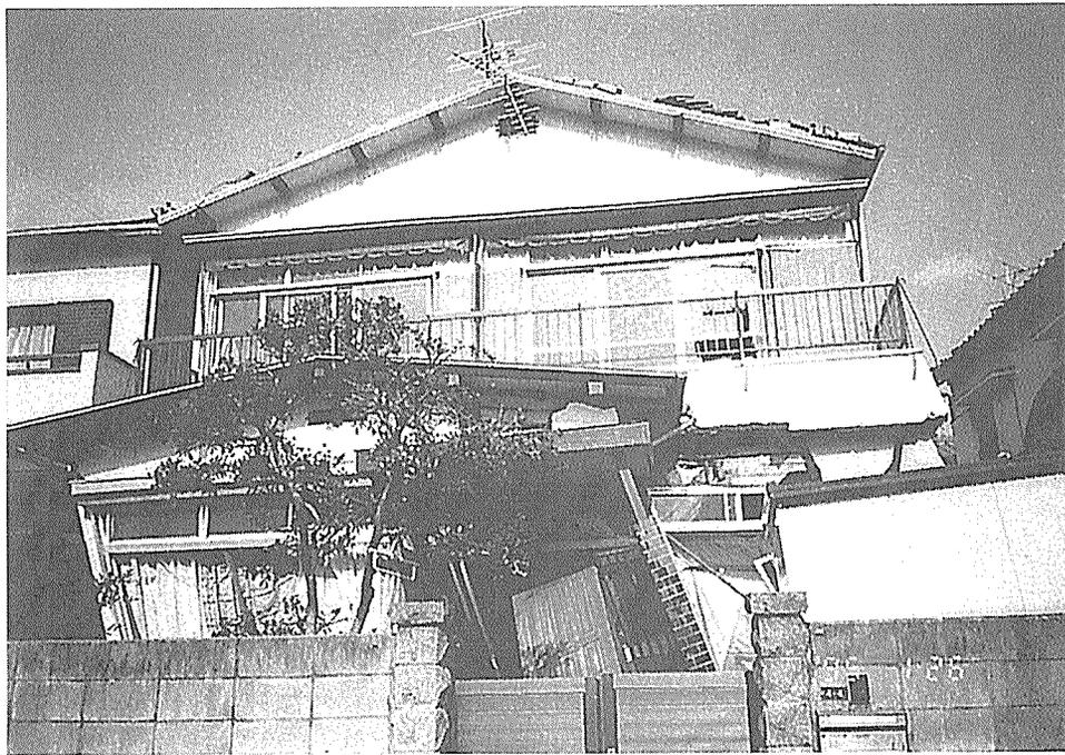
写真2.5.3.6 1階部分に大きな傾斜が生じた2階建て住宅（東灘区森南町）
