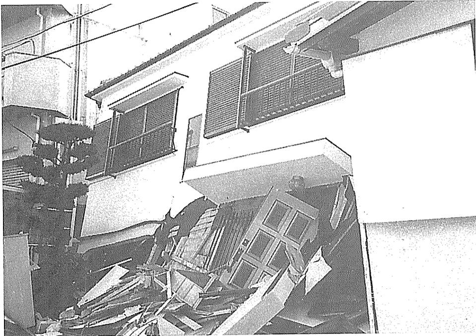
写真2.5.3.22 1階部分が層崩壊した比較的新しい在来構法
