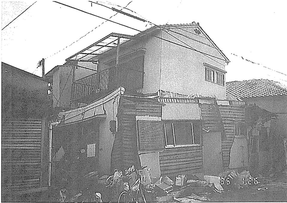
写真2.5.3.9 外壁が傾斜して、外装材が脱落した2階建て建物
