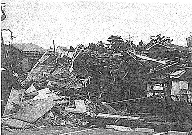
写真1 全壊した土塗壁の住宅。元の形が全く判らない(芦屋市)
