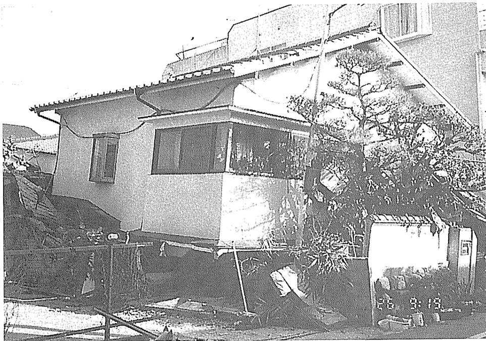
写真2.5.3.17 1階部分が層崩壊した比較的新しい在来構法による住宅。(東灘；NO.2)
