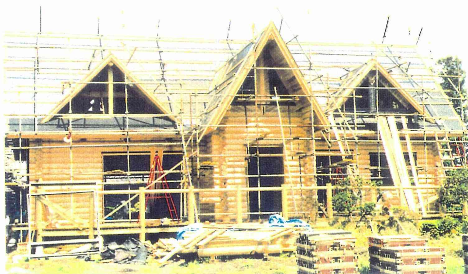
建設途中のログ ハウス異常無し
