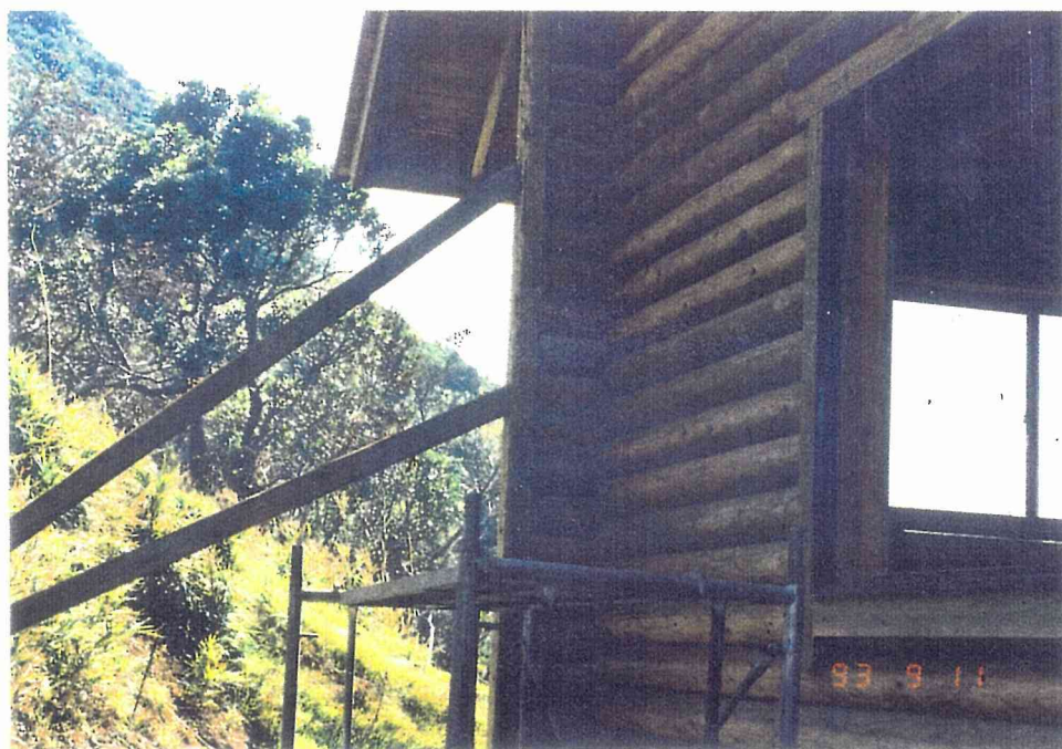
50トンジャッキによる復旧作業
