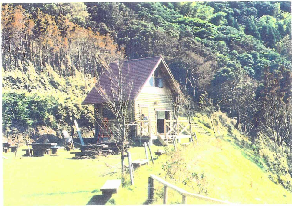
強風で傾斜した建物が 元に戻した。
