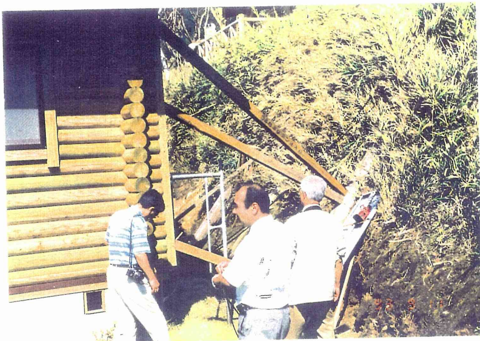
50トンジャッキによる復旧作業
