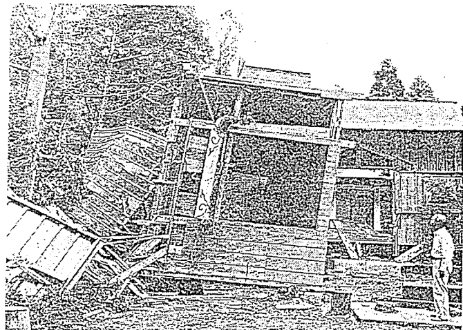
手前左が吹き飛ばされ、横転した拝殿。後ろは神殿
