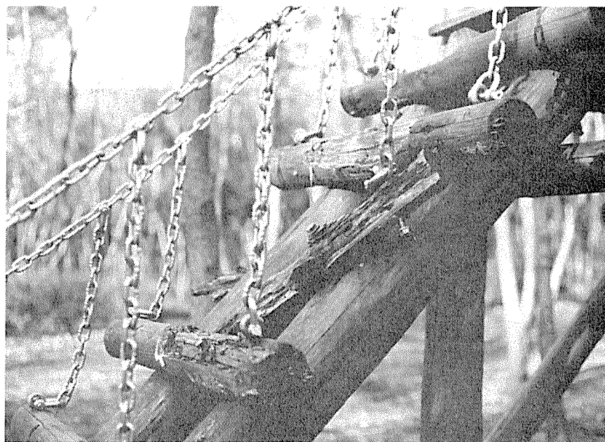
写真5 3年半で腐朽を生じたスギ丸太製遊具（防腐剤は塗布のみ）
