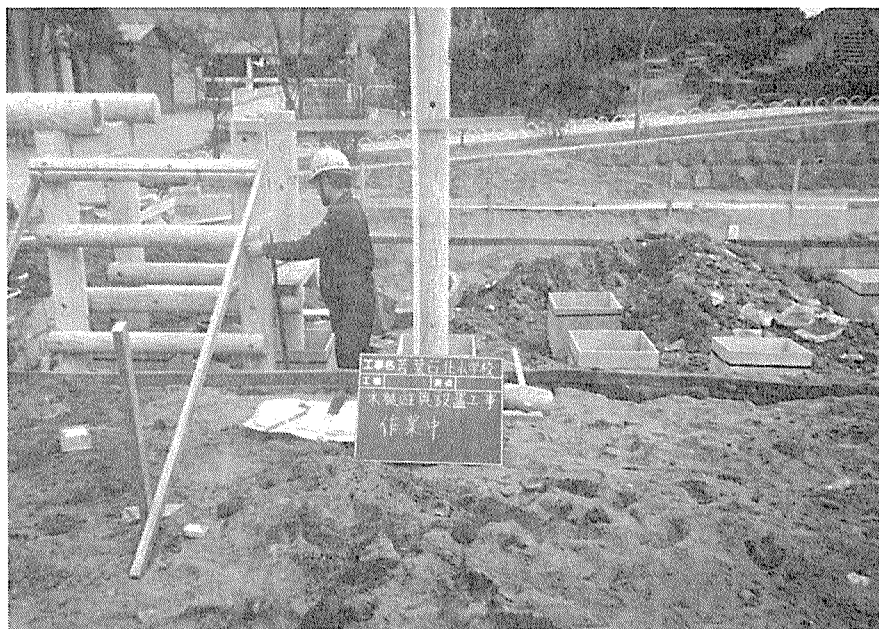
写真12 組立工事の様子
