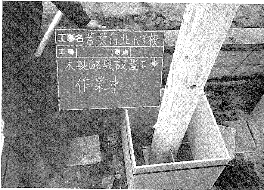
写真10 基礎の根がらみ
