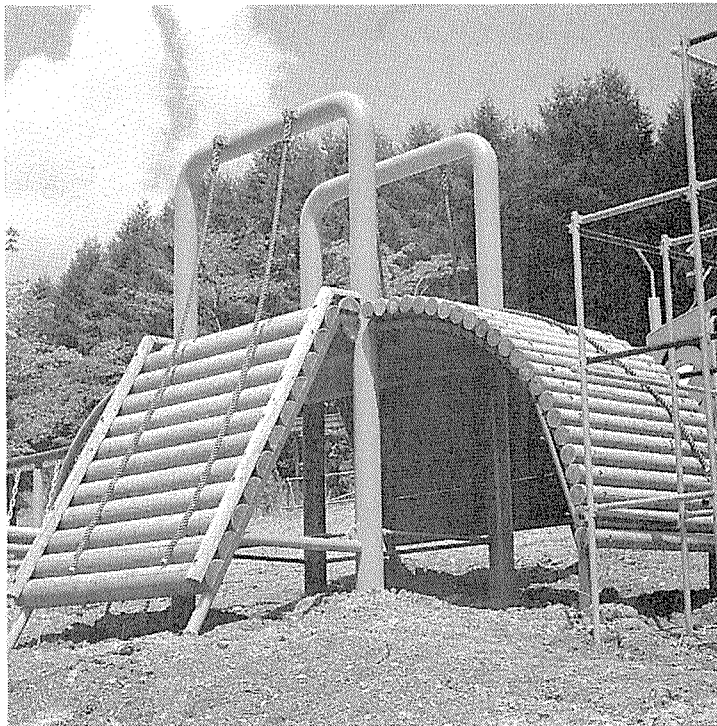
写真2 木材と金属材料を複合化した遊具
