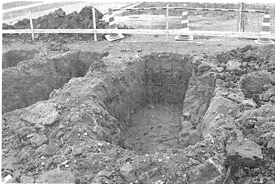
写真9 基礎の掘り込み
