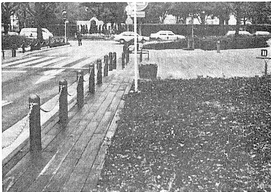
写真 1 - 2 木床舗装施工例
