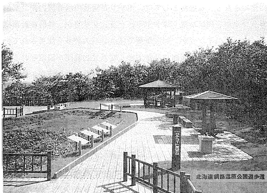
写真1-3 休憩施設まわりの木レンガ舗装
