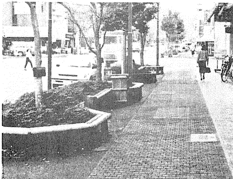
写真3-4 ヒノキの木レンガ舗装（掛川駅前）
