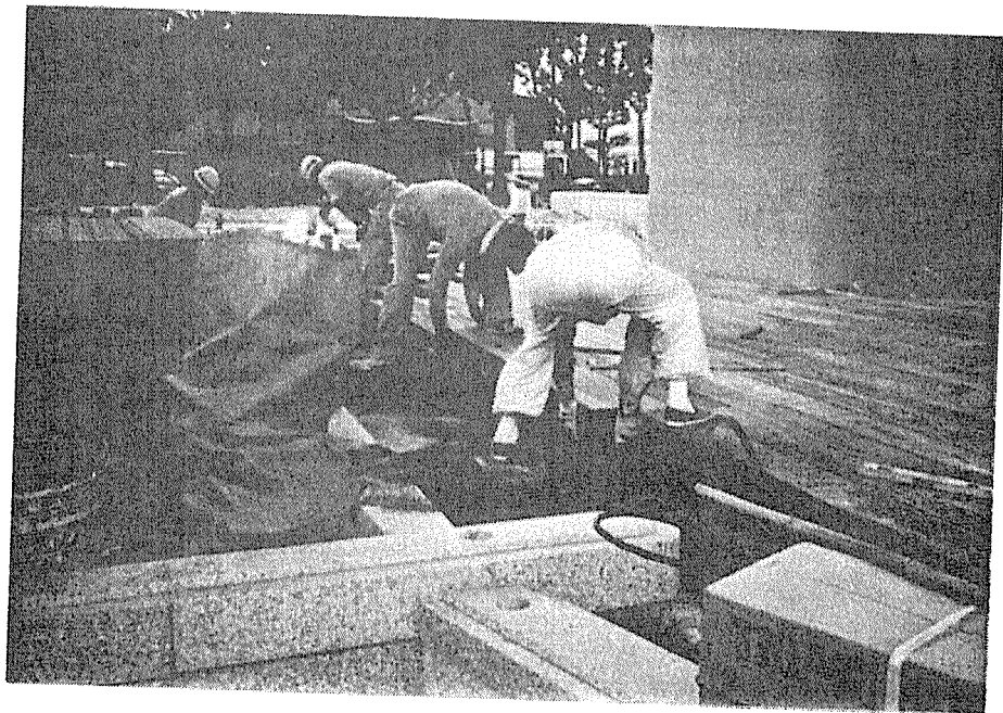
写真 4 - 5 設置タイプの施工
