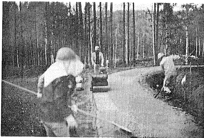
写真 4 - 8 オガクズ舗装の施工
