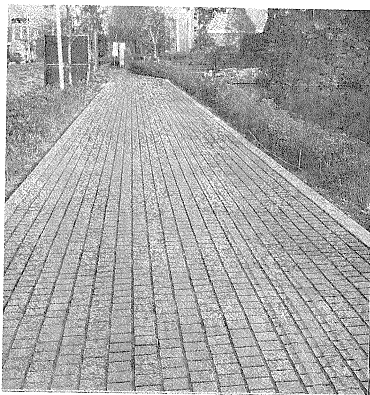
写真 1 - 1 木レンガ舗装施工例
