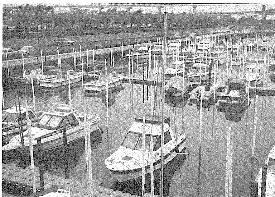
写真8 ユニットタイプの浮棧橋ユニット
