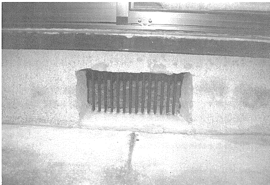
写真5-4 新たに開けられた床下換気口（事例4）
