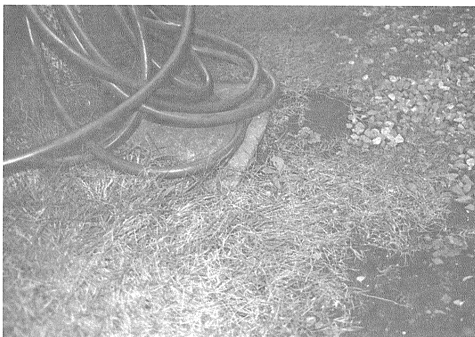
写真5-3 地面より高い庭の排水口（事例4）
