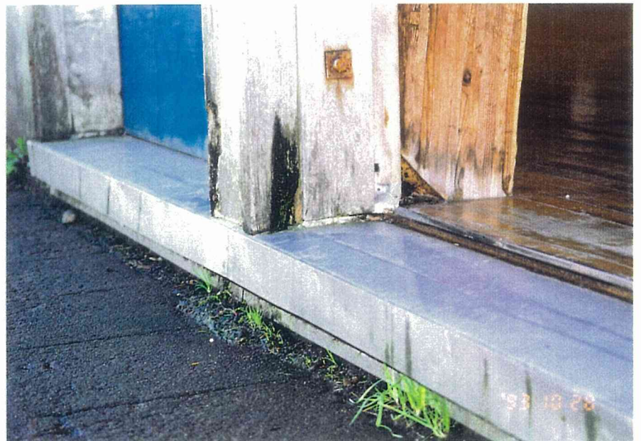
写真2-26 小学校体育館：出入口の柱脚部
