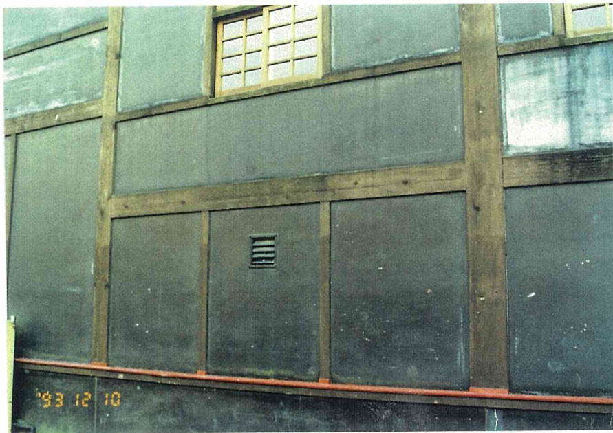
写真2-16 高等学校体育館：屋外に露出している架構
