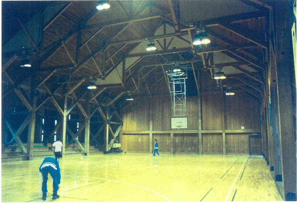
写真2-1 高等学校体育館：変形トラス
