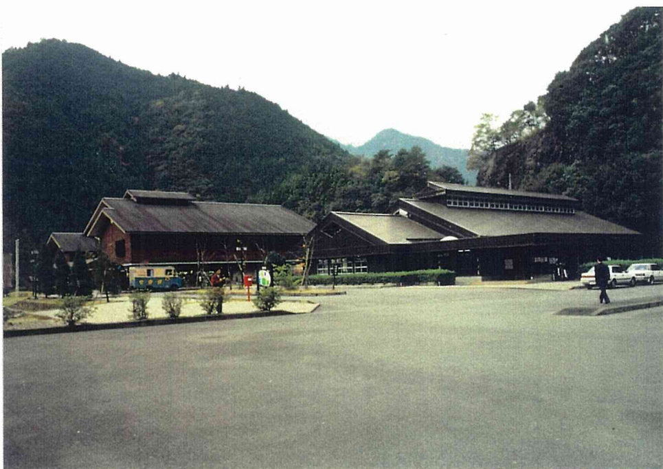
写真2-30 温水プール：全景（大きな越屋根）
