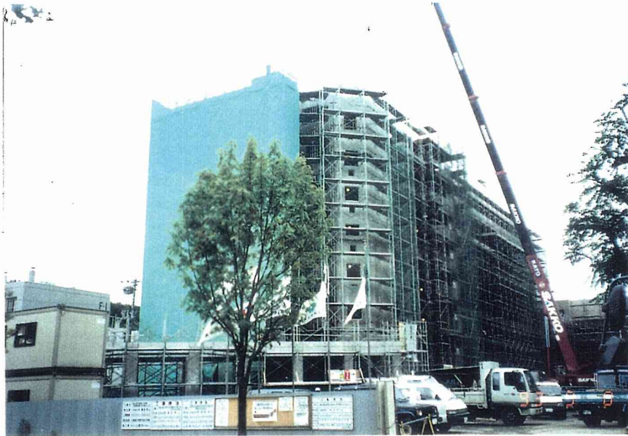
写真 5 - 6 実証化試験を実施した高層住宅
