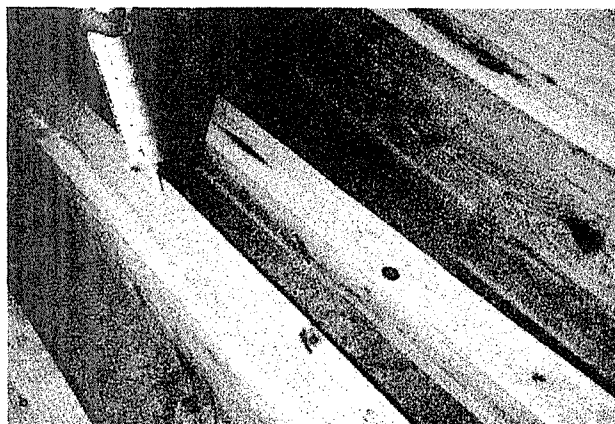
写真2-2 コーキングガンによる接着剤の塗布
