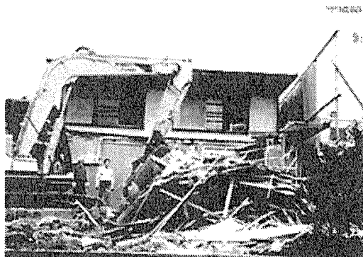
写真 4.2 機械作業分別解体現場
