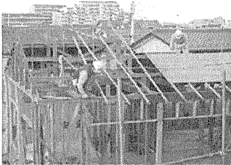
写真 4.11 野地板の撤去
