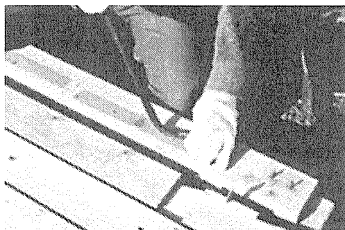
写真 5.5 パールによる釘抜き
