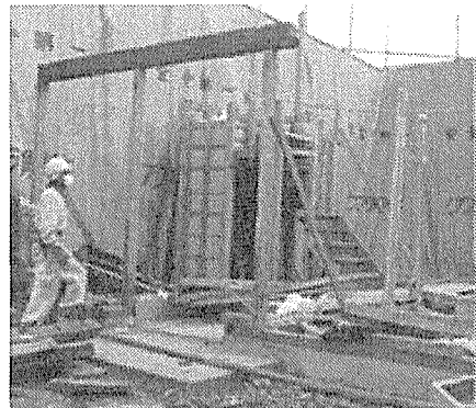
写真 4.15 1階軸組の撤去
