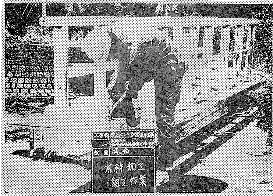
(渡り橋組み立て)
