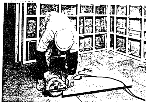
写真4-23 マンションに施工しているパーティクルボードの置床パネル
