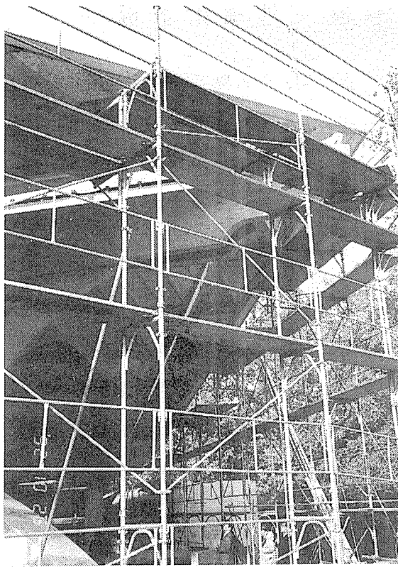
スイス、モージュの スケート場工事現場 の合板足場板（針葉 樹）
