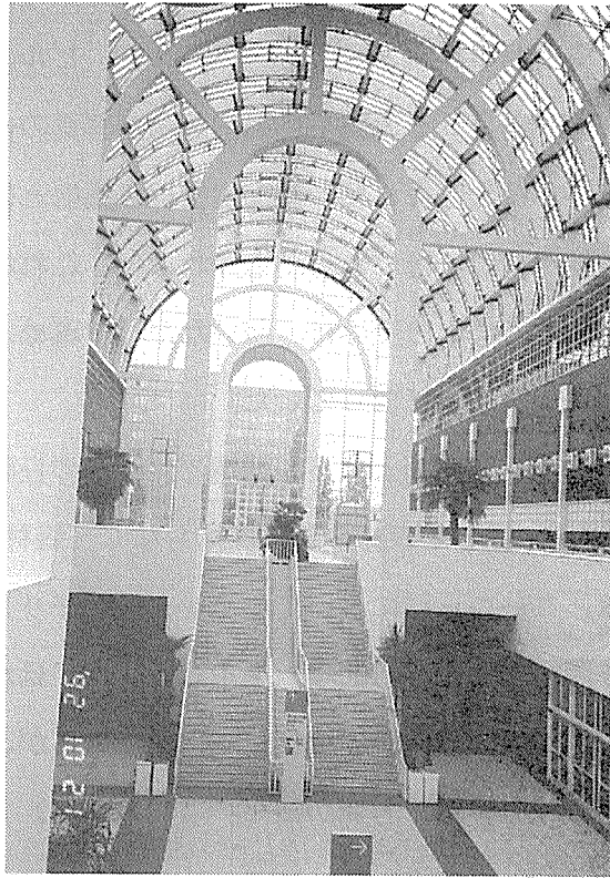
ドイツ、フランクフルトの国際見本市会場、穹曲集成材と鉄製支柱（合板で化粧されている）
