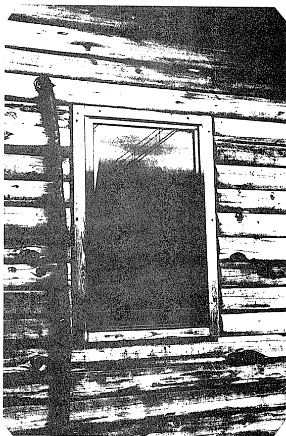
写真17 ログハウス8-2の窓枠固定状況
