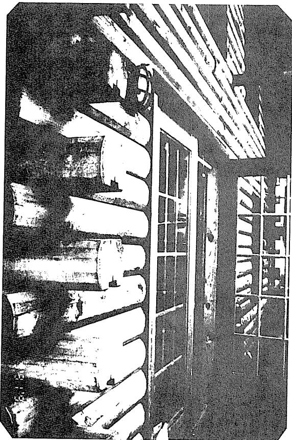
写真2 ログハウス5の壁体と木製サッシュ
