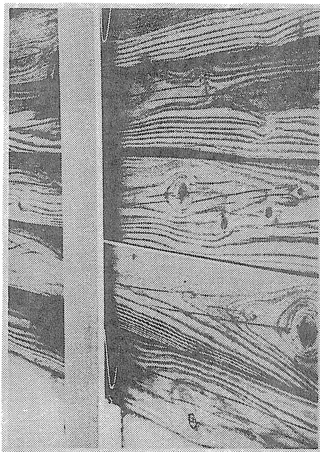
図4 -4 木製遮音壁のH型鋼による支持
