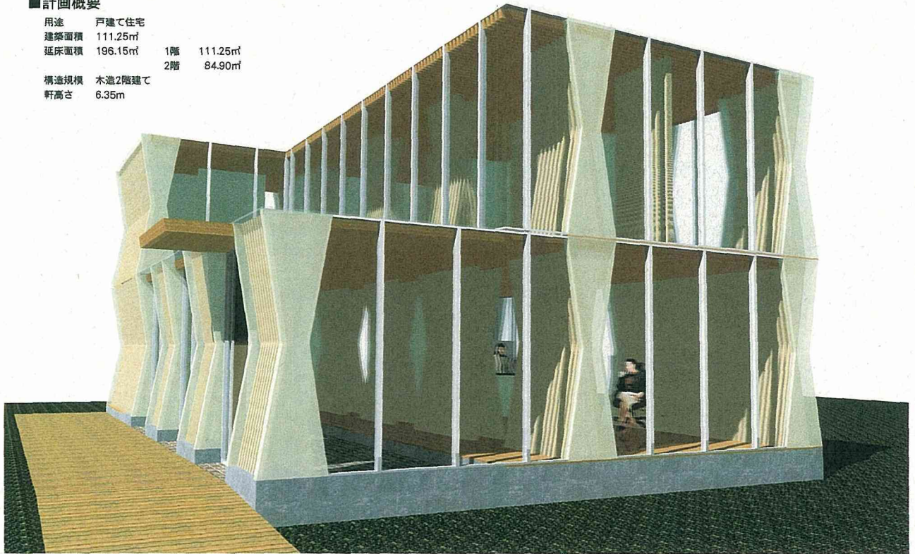
▲外觀イメージ/一方向ラーメン構造により、開放的な空間構成が可能となる。
