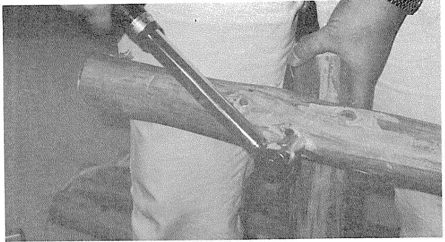
写真5. トルクレンチによる一定トルク締め
